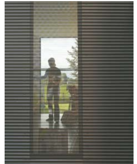
Halbtransparente Ein- und Ausblicke durch perforierte Wellprofile
