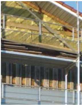
Die ältere Bretterfassade eines Betriebsgebäudes in Metzingen musste einer Außenwandbekleidung aus Titanzink-Fertigteilen weichen
