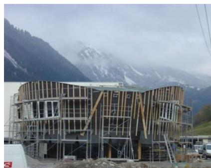
Unterkonstruktion aus Holz
