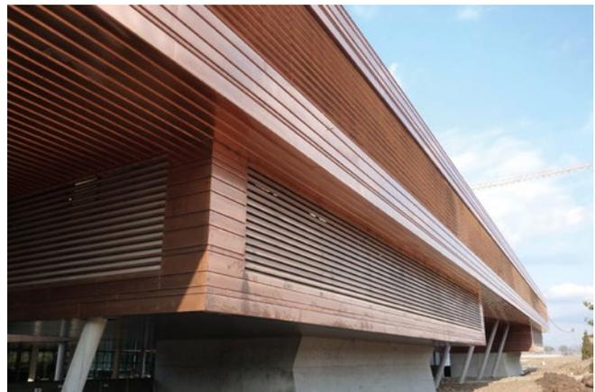
Horizontale Verlegung in unterschiedlichen Längen und Breiten
