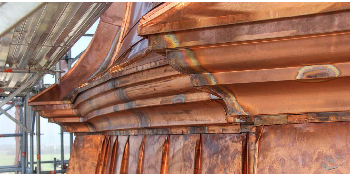
Übergang: Von der unteren Zwiebel aufsteigende Scharen greifen unter das abgetrepte Sockelgesims der Laterne
