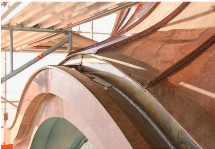
Die bogenförmig geschwungene Kastenrinne mit abgestuftem Gesims über einem der vier Zifferblätter der Turmuhr
