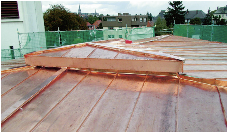
Bild 8.: Lüfterlaterne am Hochpunkt einer Walm-dachseite.
