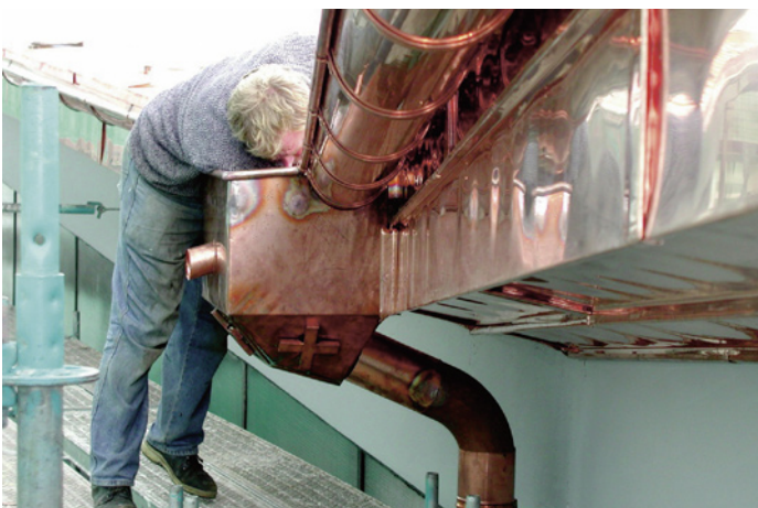
Bild 5: Gesimskasten mit Sammelkasten am Tiefpunkt des Daches.
