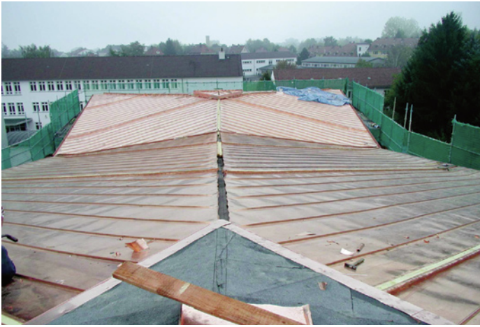
Bild 3: Dachlandschaft mit den durch Dehnungsleisten unterteilten Verlegefeldern.
