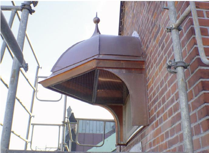
Eine von elf neuen Windenhauben, die jetzt als Ansaugöffnung für die Zuluft dienen. Um das Eindringen von Schnee oder Schlagregen weitestgehend auszuschließen, erhielten die Windenhauben seitliche Wangenteile.
