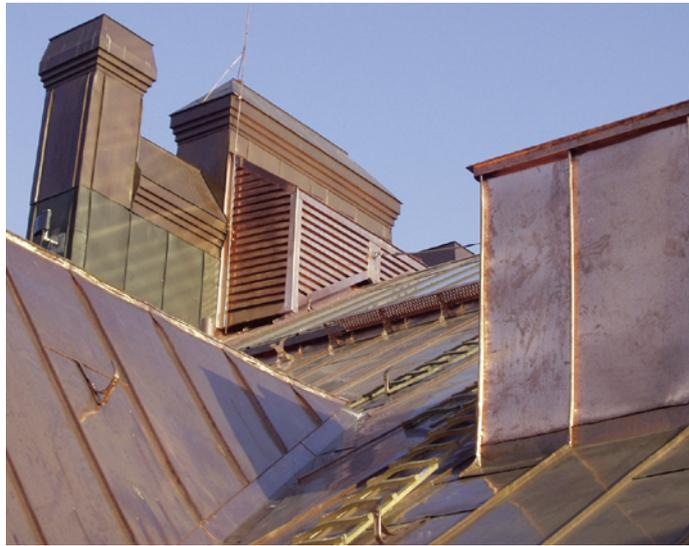
Mit Kupfer neu gedeckte und bekleidete Dach- und Wandflächen sowie Einhausungen mit Kupfer-Lüftungslamellen.
