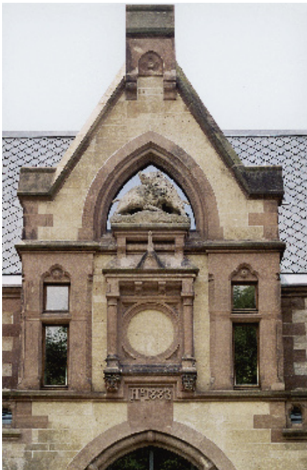
Bild 9.: Nach der Renovierung ist die Jahreszahl über dem Eingang wieder zu erkennen: 1883 erfolgte die Fertigstellung der Vorburg. Die neue Rautendeckung aus Rheinzink ist nach wenigen Jahren gleichmäßig natürlich bewittert.
