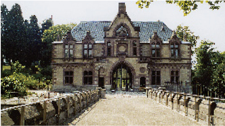
Bild 3.: Die Vorburg des Schlosses Drachenburg strahlt wieder in alter Schönheit. Das Metalldach in Rautendeckung ist originalgetreu wieder hergestellt.
