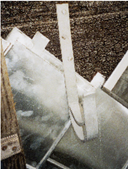
Bild 6.: Baustellendetail Rautendeckung im Bereich eines Leiterhakens: Die Befestigung mit Haften und die traufseitig angeformten Wulste sind ebenso erkennbar wie die oberen Einhangfalze der Rauten.
