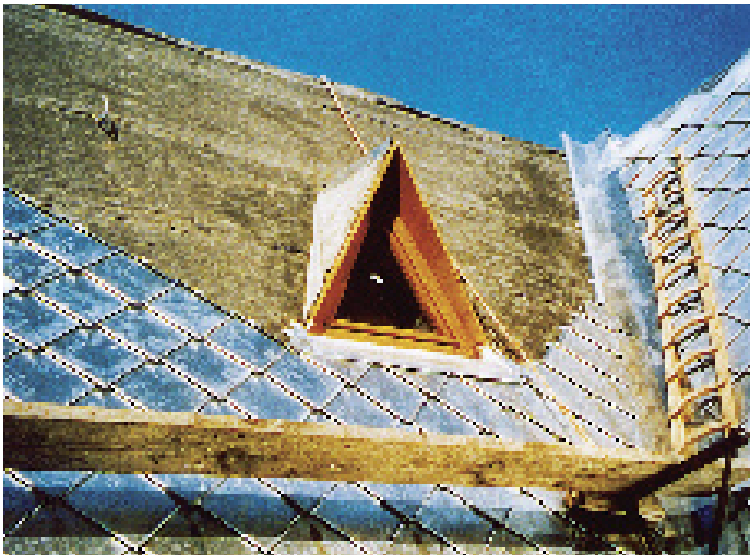
Bild 8.: Baustellensituation bei der Neudeckung. Insgesamt waren rund 10 000 m 2 Rauten der Abmessung 333 x 333 x 0,8 mm nach altem Muster neu anzufertigen.
