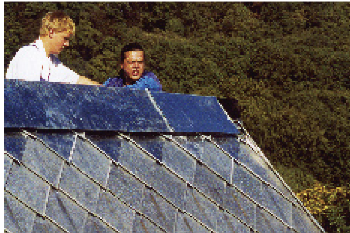
Bild 6.: Baustellendetail Rautendeckung im Bereich eines Leiterhakens: Die Befestigung mit Haften und die traufseitig angeformten Wulste sind ebenso erkennbar wie die oberen Einhangfalze der Rauten.
