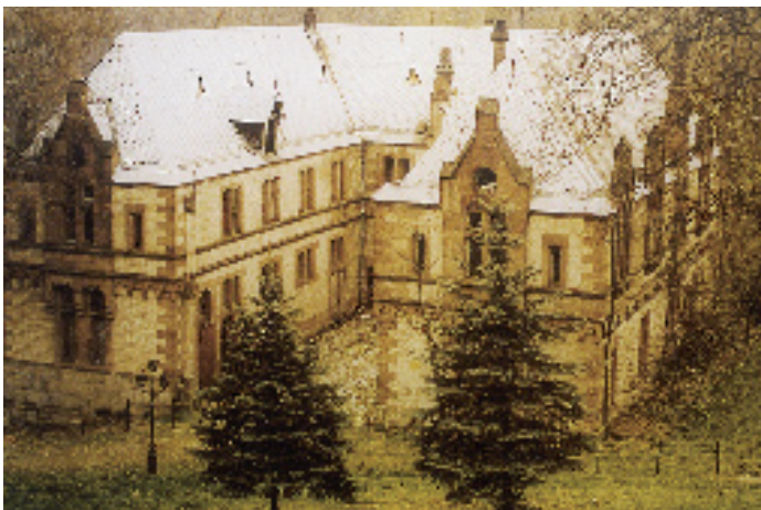
Bild 4.: Die Vorburg zu Beginn des 20. Jahrhunderts mit seinem ursprünglich offenen Innenhof und das mit Zink-Rauten gedeckte Walmdach im ursprünglichen Zustand.
