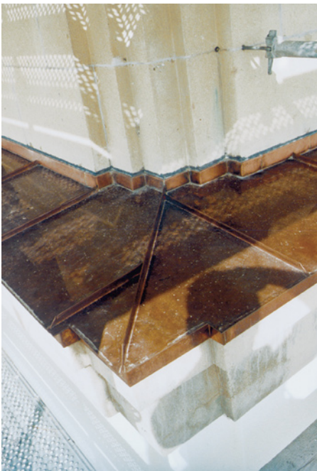
Bild 5.: Schnittstelle an einer Mauerabdeckung mit stehend ausgeführten Doppelstehfalzen. Die Anschlüsse an das aufgehende Mauerwerk haben an ihrer Oberkante einen Umschlag und sind in eine gefräste Nut eingeführt, die anschließend mit Bleiwolle ausgestemmt wird.
