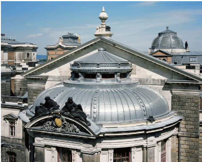
Bild 12.: Hochschule für bildende Künste in Dresden: Zinkdächer sind auch mit anspruchsvollen Geometrien bei Baudenkmalern eine gute Lösung. Ausführung der Klempnerarbeiten: Böhme Haustechnik GmbH, Dresden. (Foto: Rheinzink, Datteln).
