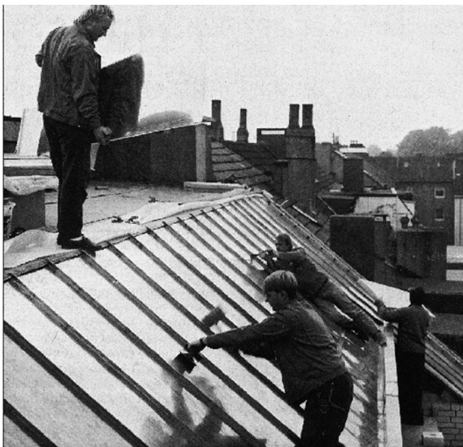
Metalldächer werden von den Betrieben des Dachdeckerhandwerks heute auch beim Wohnhausbau oder der Renovierung verlegt. FOTO: DACHDECKER-INNUNG
