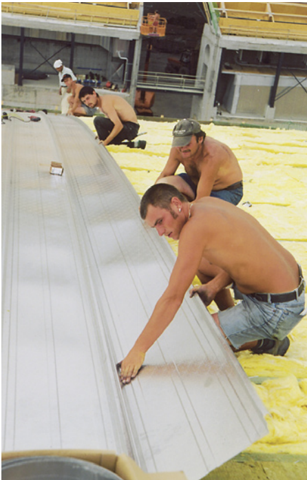
Ein letzter Kontrollblick ist unerlässlich, bevor die Profilbahn eingeklickt wird.
