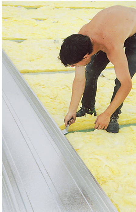
Die speziell auf die Geometrie der Rib-Roof-Profilbahnen abgestimmten Befestigungselemente werden in den Falz eingehängt ...
