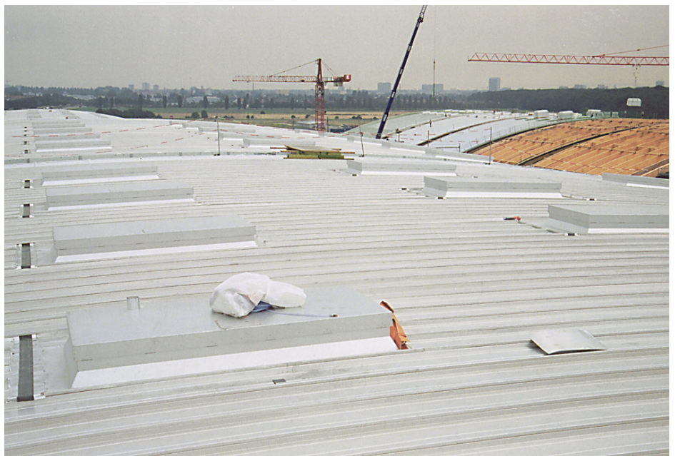
Vom bereits fertiggestellten Dach der Mehrzweckhalle, welche die anderen um gut vier Meter überragt, gleitet der Blick über die Dachlandschaft hinweg zu den noch in Arbeit befindlichen Flächen.
