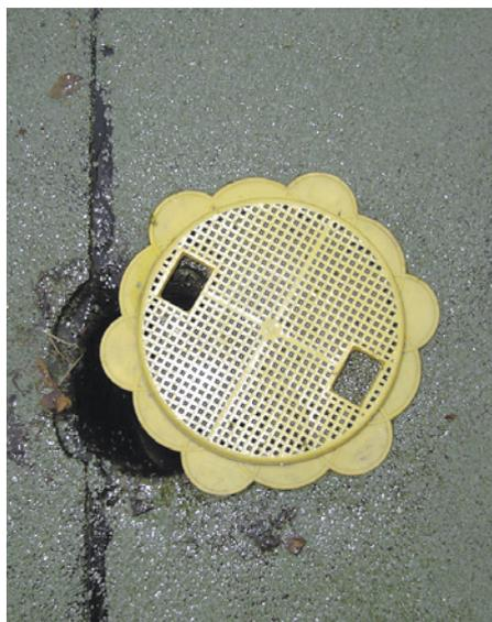
**Bild 2.:** Hier kommt ein Sandkasten-Sieb anstelle eines Kieskastens zum Einsatz.
