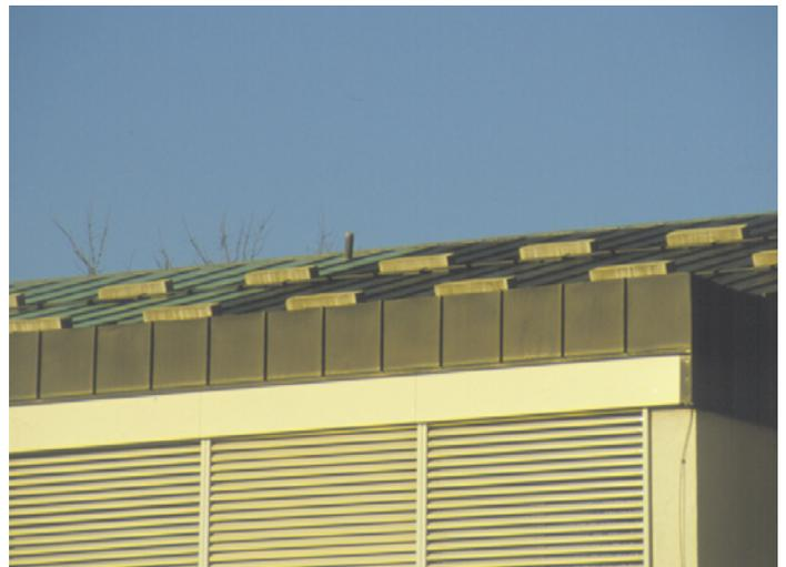
**Bild 8.:** Auf Schneefangrohren liegende Betonquader „beschweren“ ein Kupferdach.
