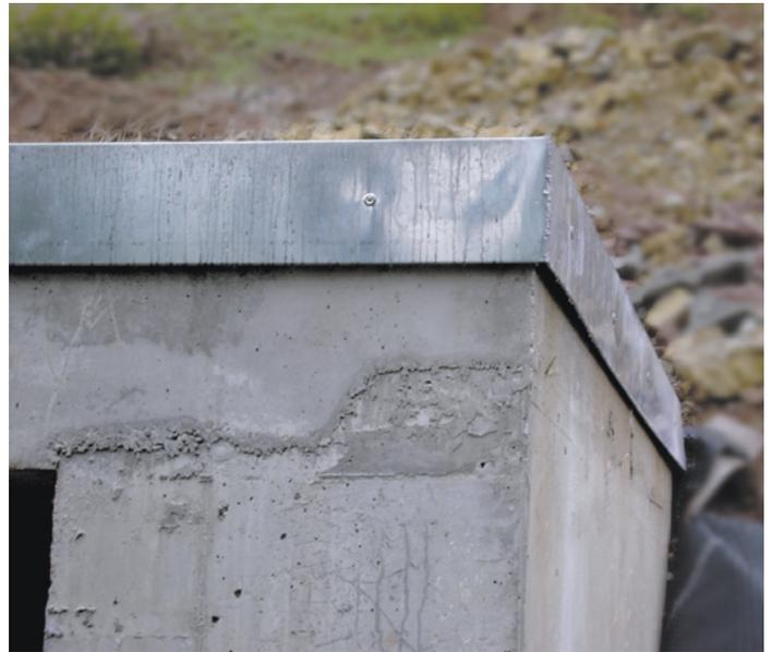
**Bild 6.:** Durch Spenglerschrauben mit Dichtscheiben ist diese Attika für jeden sichtbar befestigt. Man könnte auch sagen: Eine senkrechte Eck-Lötnaht als Falzersatz.
