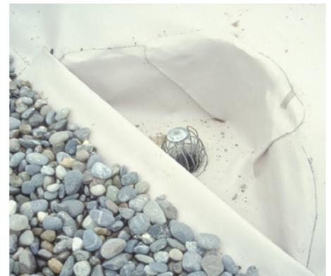
**Bild 3.:** Auch Laubfangkörbe aus Stahl Draht werden als Ersatz für Kieskästen zweckentfremdet.
