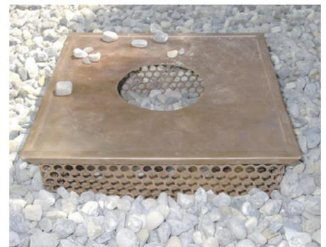
**Bild 4.:** Der gute alte Kiesfangkasten scheint längst nicht mehr attraktiv zu sein.
