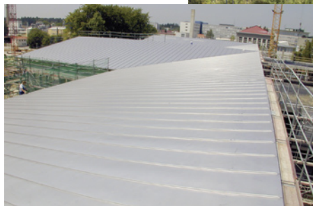
... eine insgesamt 6450 m 2 große Dachfläche, gedeckt von Spenglern des Fachbetriebs Johannes Binder mit Edelstahl der Marke Ugitop, Werkstoffnummer 1.4301 (Chrom-Nickelstahl).
