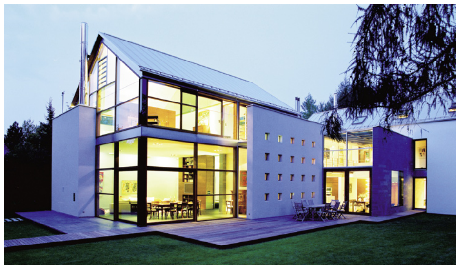
Wohnhaus in Pullach bei München, entworfen von dem Architekturbüro Stadler + Partner aus München. Dachdeckung durch den Spengler-Fachbetrieb Johannes Binder, Ingolstadt mit walmattiertem Edelstahl der Marke Ugitop, Werkstoffnummer 1.4301 (Chrom-Nickelstahl). (Foto: Johannes Binder, Ingolstadt)
