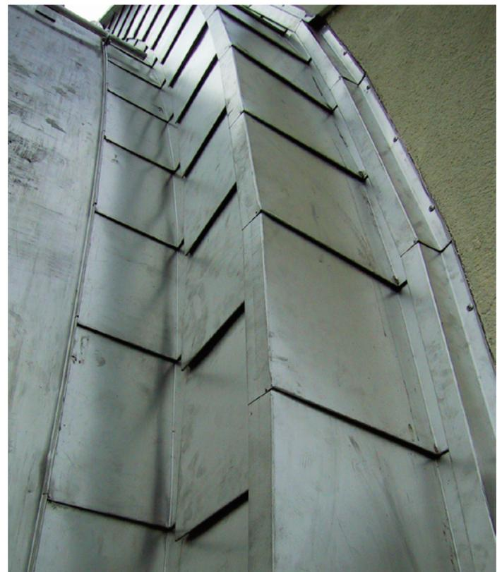
Detail einer Hexentreppenkehle bei einer besonders komplizierten Anschlusssituation an eine wärme gedämmte Brandschutzwand. Die verwendete Wärmedämmung entspricht der Brandschutzklasse A1. Die Deckung des gerundeten Dachs und auch die der Brandschutzwand wurde durch einzelne Edelstahlsegmente bewerkstelligt, die durch einfache Liegefalze miteinander verbunden sind.
