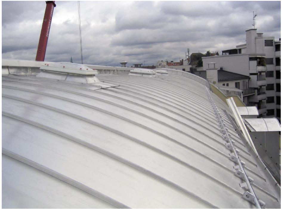
... seiner 32 m langen First-Labyrinth-Entlüftungsleiste sowie dem Rohr-Schneefangsystem aus Edelstahl und Eisstopfern aus Aluminium.
