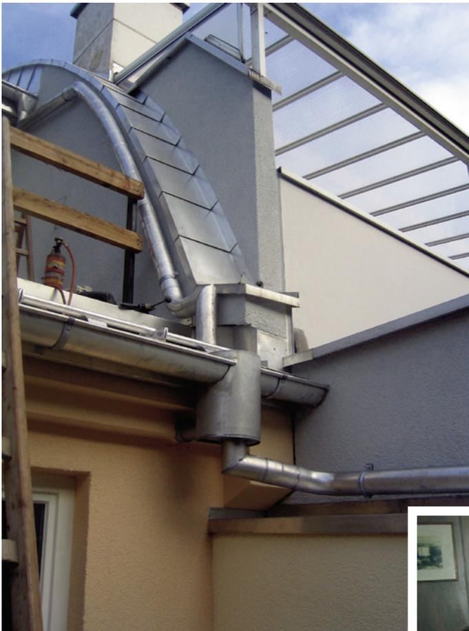
Ganz schön kompliziert präsentiert sich die Dachentwässerung. Die Verbindungen sind weich gelötet - aus Gründen der Farbanpassung mit Stangenzinn - unter Verwendung des Flussmittels Ferrinox 4000.
