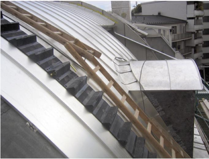
Bei den Klempnerarbeiten nutzen die Mitarbeiter des Fachbetriebs Rembold nicht nur Holzleitern, sondern auch eine praktische Kautschuk-Arbeitsstreppe mit dem Namen Flexostep, die besonders für die Arbeit auf gerundeten und gewölbten Dachflächen geeignet ist (BAUMETALL 3/2002, Seite 73).
