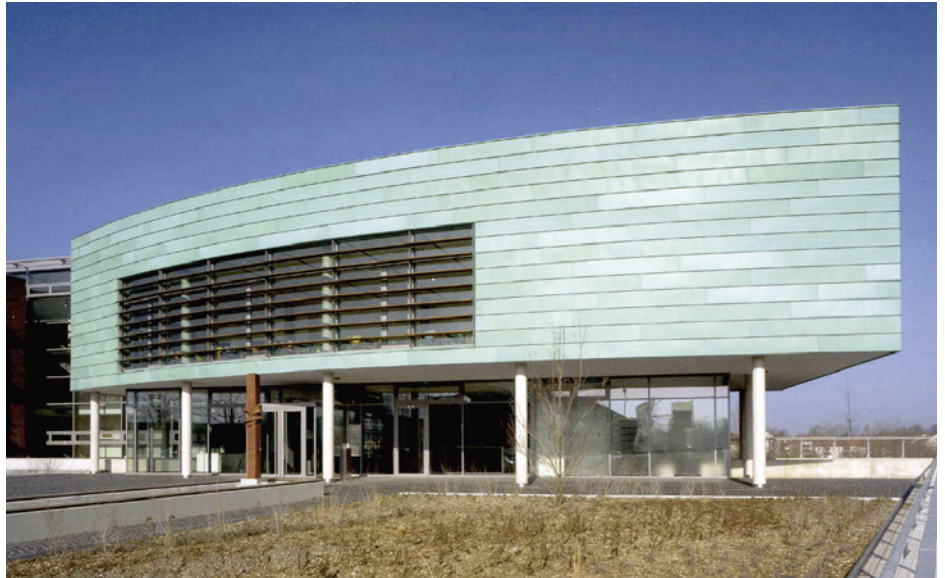
Das Bürogebäude des Bauunternehmens Köster in Osnabrück hat eine etwa 800 m 2 große Außenwandbekleidung aus werkseitig vorpatiniertem Kupfer der Marke Tecu-Patina von der KM Europa Metal AG (KME) aus Osnabrück.
