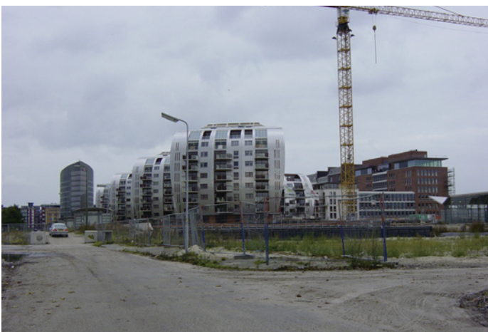
Eine von großartigen Architekten auf dem Reißbrett geplante Neustadt entsteht am Stadtrand von ‚s Hertogenbosch. Rund 6500 m 2 Edelstahl kamen bei diesem Teil der Neubauten zum Einsatz. Die Ausführung der Klempnerarbeiten übernahm die Firma Verkoelen in Zusammenarbeit mit dem thüringischen Klempner-Fachbetrieb Jens Sperber aus Langenschade.
