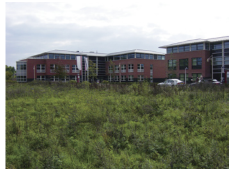
Auf den Weg nach ‚s Hertogenbosch ein Zwischenstopp in Eindhoven: 10 000 m 2 Titanzink in Doppelstehfalztechnik verarbeiteten die Fachleute der Firma Verkoelen an diesem Bürogebäude.
