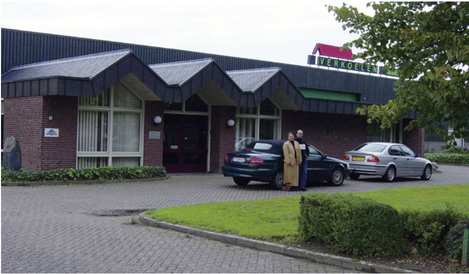
Blick auf den Eingangsbereich der Firma Verkoelen in Beegden mit den kupferbekleideten, in Stehfalztechnik gefertigten Ortgängen. Den Grundstein für dieses Gebäude legte Jos im Auftrag seines Vaters Harry am 24. März 1978 - im Alter von neun Jahren!
