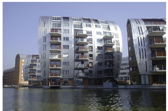
Die Fassaden scheinen auf dem Wasser zu schweben. Die maximale Zuschnittlänge der einzelnen Scharen betrug 1200 mm und viele der Querfalze sind schräg angeordnet. Die Fassaden erinnern an aufgeblähte Segel, die Beulen sind von dem englischen Architekten gewollt, denn sie sollen Ausdruck einer lebendigen Architektur sein.
