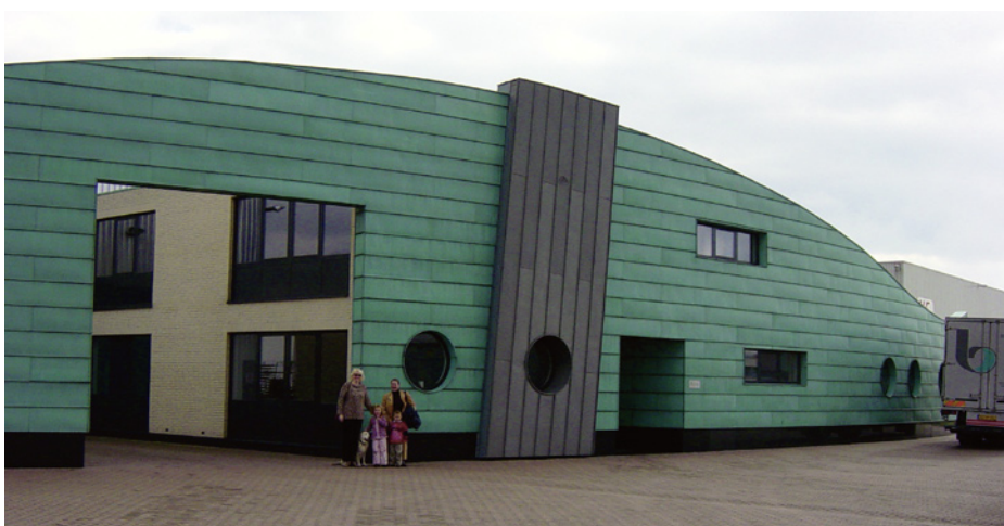
Moderne Architektur prägt die Fassade von Brouwers Zink BV im belgischen Maasmechelen bei Maastricht. Rund 400 m 2 vorpatiniertes Kupfer der Marke Tecu-Patina und auch vorbewittertes Zink der Marke NedZink Art zieren und schützen die Fassade. Im Bild rechts einer der neun firmeneigenen Lkws mit dem Firmensignet: einem aus Metallband geformten „b“ für Brouwers.
