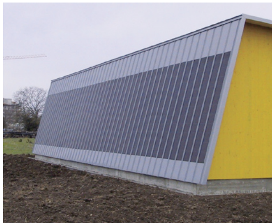
Bild 2.: Photovoltaik mit Rheinzink Solar PV in Doppelstehfalztechnik.
