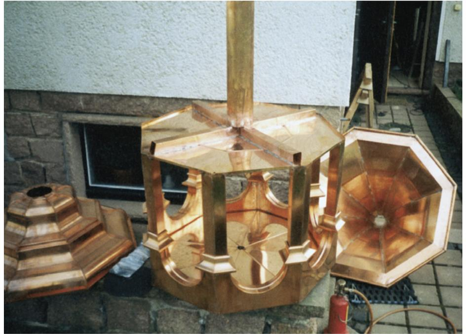
**Bild 2.:** Die Einzelteile vor der Montage (v. l.): der Sockel, das auf dem Kopf stehende Mittelteil mit Säulen und Rundbögen und das von innen punktuell verlötete Dach.
