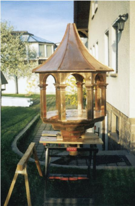
**Bild 4.: Das Ende der mühseligen Arbeit ist in Sicht. Jetzt fehlen nur noch Wetterfahne und Bodeneinfassung.**
