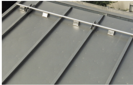
... die darunter angeordnete Wirrfaser-Trennlage verstärkt nach Auffassung der Teilnehmer die optische Beeinträchtigung.
