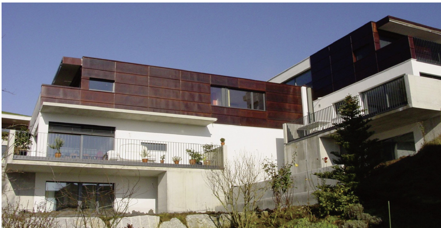
Südwest-Ansicht des Zweifamilienhauses: Der warme dunkelbraune Farbton von Tecu-Oxid für das Obergeschoss hebt sich deutlich ab von dem hellen Weiß der Betonflächen. Die übrigen Außenmauern sind in einem dunkleren Weiß gehalten.
