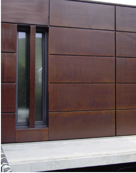
Detailansicht der Nordseite. Bestehend aus saubere Verlegung der handwerklich gefertigten Kassetten.
