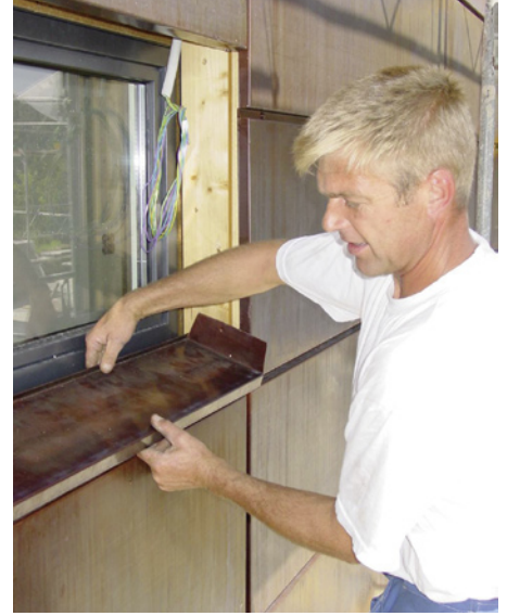
Spenglermeister Georg Hebler bei der Montage einer Fensterbank aus Tecu-Oxid.
