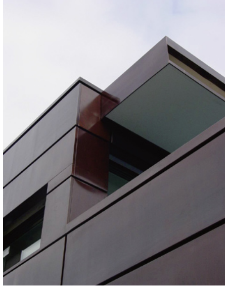
Das Gleiche gilt für diese Detailansicht von der Südseite.
