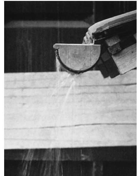
Rinne rückseitig tiefer - das überlaufende Regenwasser läuft von der Wand weg.
