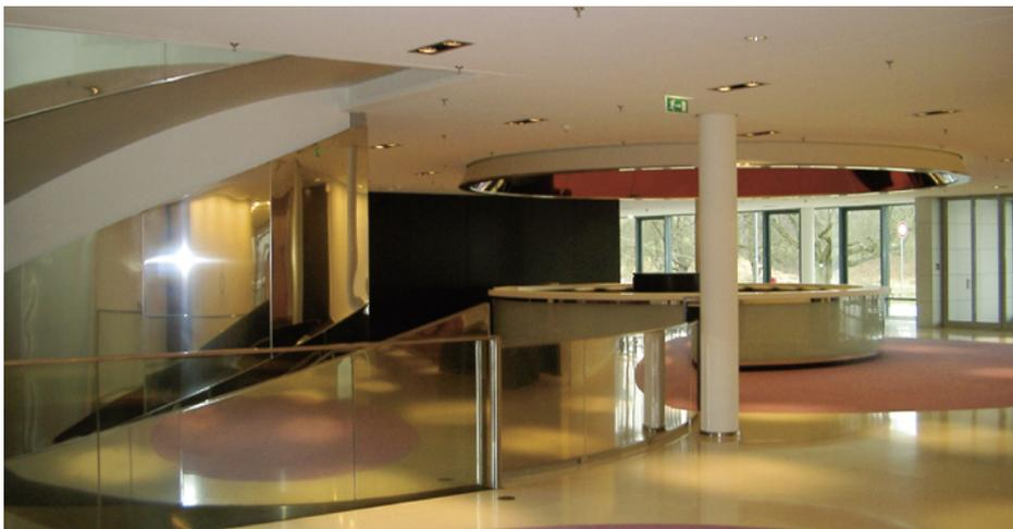
Bekleidung des Aufzugschachtes mit 0,8 mm dickem Edelstahl der Werkstoffnummer 1.4301 auf einer Unterkonstruktion aus verzinkten Stahlprofilen. Ebenfalls zum Auftragsumfang gehörte die Verlegung des Edelstahlhandlaufs (60 x 8 mm), befestigt mit Blechschwertern. Bei diesen handelt es sich um Laserzuschnitte aus Edelstahl mit einer Materialdicke von 4 mm.
