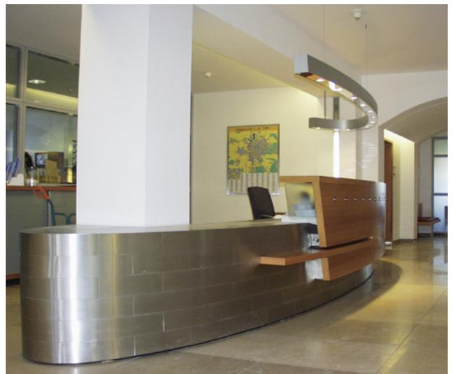
Die Empfangstheke im Rathaus von Neumarkt hat eine Bekleidung aus 0,8 mm dicken Edelstahl-Schindeln mit geschliffener Oberfläche. Auch die Deckplatte der Empfangstheke ist mit diesem Material bekleidet.
