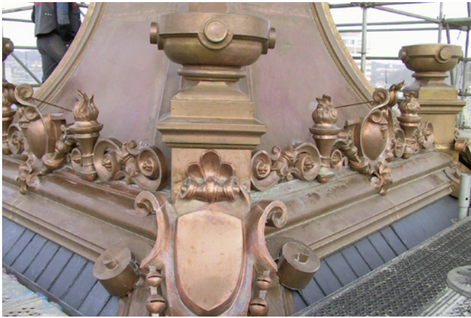
Ein weiterer Blick auf die prachtvollen, neu hergestellten Ornamente.
