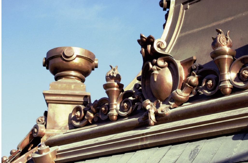
Nun sind auch alle Zierornamente am Fuß der Kupferlaterne montiert und erstrahlen in neuem Glanz.
