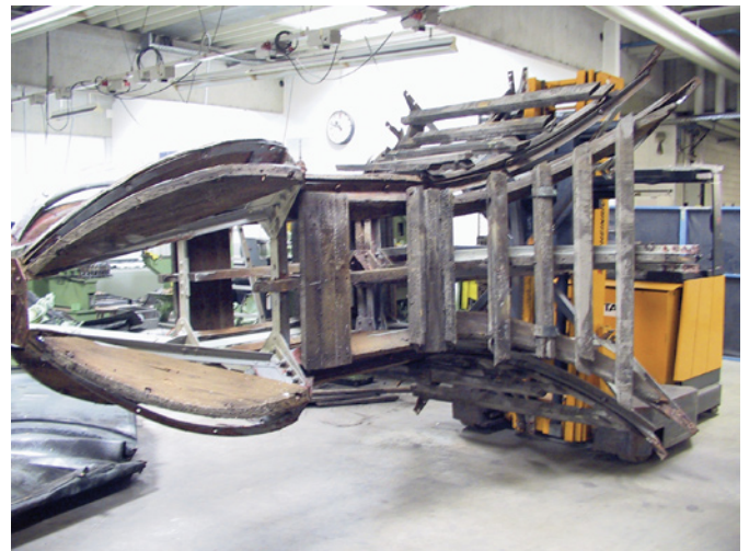
Nach dem Entfernen der Kupferbekleidung in der Werkstatt von Kaufmann Ulm zeigte sich dieses vermoderte Holzgerippe...
