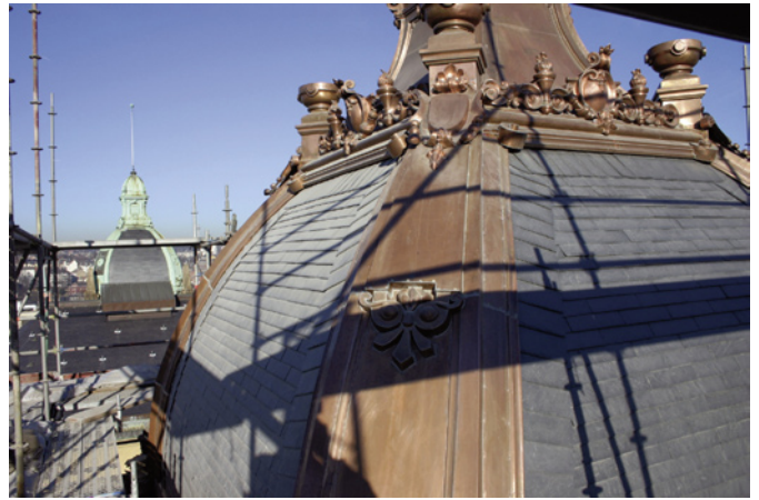
Inzwischen ist auch die von Kaufmann Ulm vorgefertigte Gratabdeckung montiert. Im Bildhintergrund eine der beiden alten Laternen, deren Neuanfertigung im April dieses Jahres bei Kaufmann Ulm schon begonnen hat.
