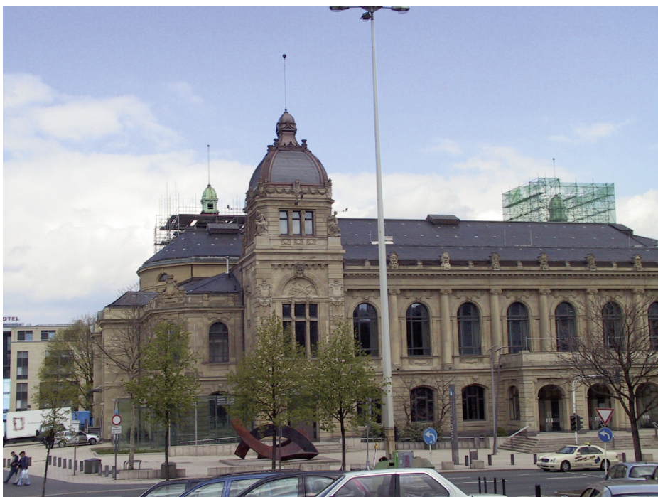
Zum Schluss noch ein Blick auf eine der beiden fertigen Laternen. Im Bildhintergrund zwei der alten Laternen, von denen eine schon eingerüstet ist.
