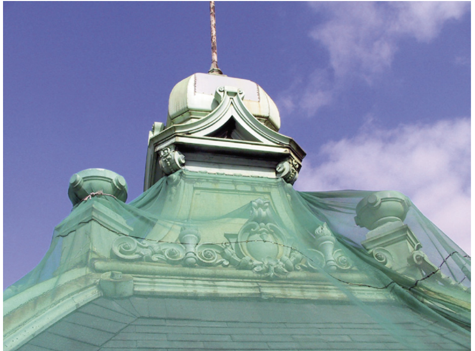
Diese schön patinierte Kupferlaterne trotzte über 100 Jahre Wind und Wetter. Aber zuletzt flogen bei Sturm Kupferteile davon...
