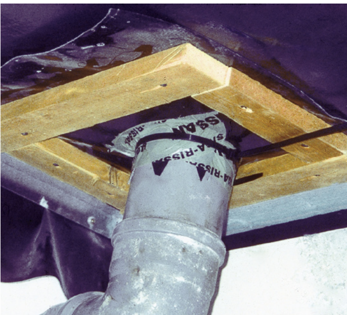
Bild 16.: Luftdichtheit, Abdichtungsmaßnahme im Bereich Anschluss geneigtes Dach an eine Wand. Hier: Anschluss mit Dichtband und mechanischer Sicherung durch aufgeschraubte Latte, siehe auch Bild 12. (Variante zu Bild 11.).
