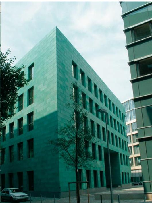
**Bild 8.:** Zum Fertigungsprogramm gehören weiterhin Steckfalzpaneele und auch Metallkassetten, wie hier am Büro- und Geschäftshaus Kai 13 in Düsseldorf.
