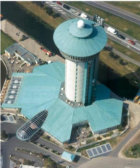
**Bild 7.:** Die Dächer des Wasserturms in Zwolle sind mit von Fricke vorprofilieren Kupferscharen gedeckt.
