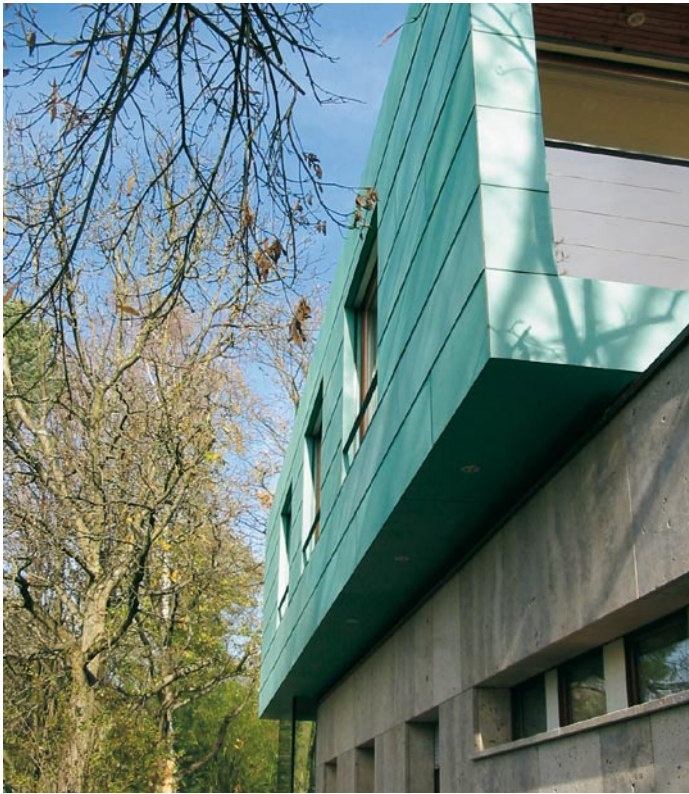
Die Untersichten des auskragenden Teils der Aufstockung sind auf der Nord- und Westseite ebenso mit werkseitig vorpatinierten Kupfertafeln...
