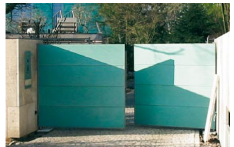
Die vorpatinierten Kupfertafeln für die Bekleidung der Hofeinfahrts-Torflügel haben eine Abmessung von 450 x 1900 mm und sind auf der Edelstahlunterkonstruktion mit SikaBond aufgeklebt.
