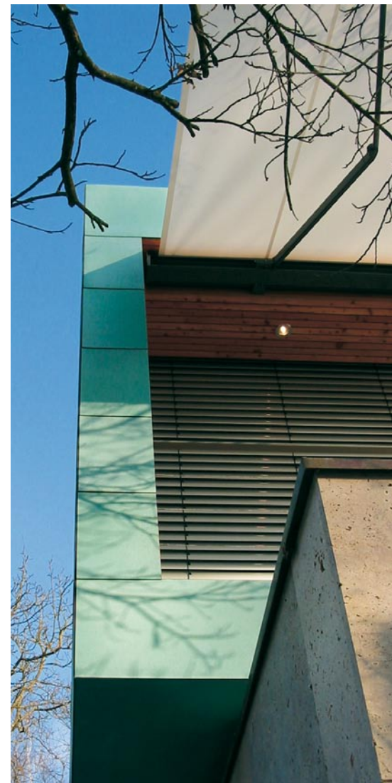
Die Südansicht zeigt eine Lisenenbekleidung der Abmessung 500 x 800 mm.
