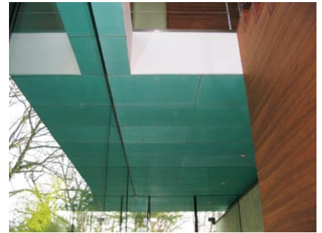
An der Nordseite setzt sich die Bekleidung der Untersichten von außen über eine Verglasung in den Innenbereich fort. Das Lindgrün der vorpatinierten Kupfertafeln harmoniert mit der Holzvertäflung ebenso...
