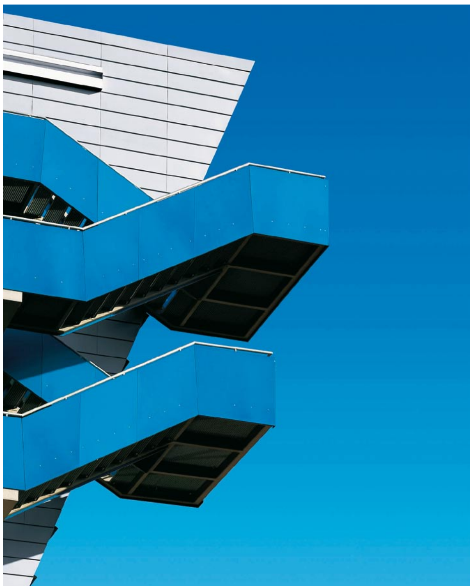
... oder mit dem kräftigen Blau der Treppenbrüstungen – das dezente Blaugrau der vorbewitterten Rheinzink-Steckfalzpaneele harmoniert in beiden Fällen.
