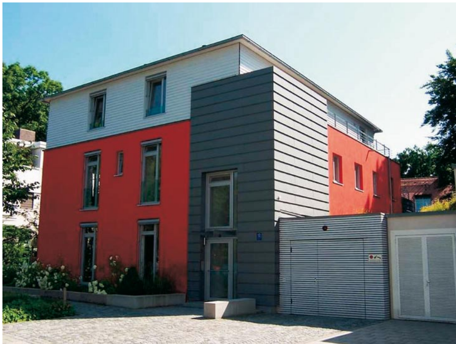
Bild 1.: Die Ansicht von Südosten zeigt den in der Farbe „erdrot“ neu verputzten Altbau, dessen Aufstockung mit einer hellgrauen Stülpschalung bekleidet ist. Rechts daneben steht der Treppenhauskubus mit einer Außenwandbekleidung in horizontaler Winkelstehfalztechnik.
