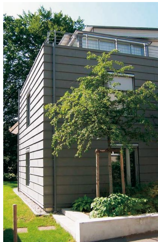
Bild 1.: Die Ansicht von Südosten zeigt den in der Farbe „erdrot“ neu verputzten Altbau, dessen Aufstockung mit einer hellgrauen Stülpschalung bekleidet ist. Rechts daneben steht der Treppenhauskubus mit einer Außenwandbekleidung in horizontaler Winkelstehfalztechnik.
