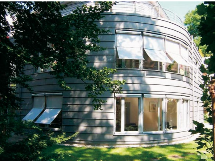
Bild 3.: Auch in der Südwest-Ansicht ergibt die streng symmetrische Einteilung eine perfekte Optik. Deutlich sichtbar: die um die Ecke durchgehenden Winkelstehfalze.
