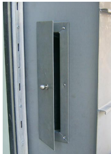
Bild 4.: Im Eingangsbereich fertigte Spenglermeister Stefan Keppeler einen in Klempnertechnik gestalteten Briefkasten...
