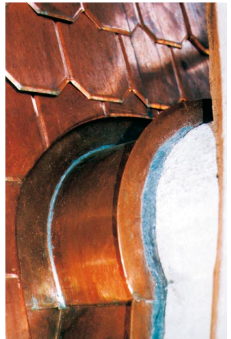
Bild 4.: Saubere Anschlussarbeiten beim Übergang von der Schindelbekleidung zu den Wimpergen. Die Anschlussfugen sind nachträglich mit Bleiwole ausgestemmt.
