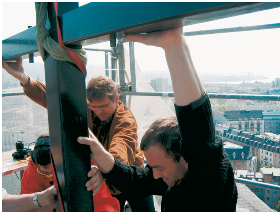
Bild 2.: Dort angekommen, wird es von Beat Scherrer (M.) und seinen Mitarbeitern in die vorbereitete Halterung geführt.
