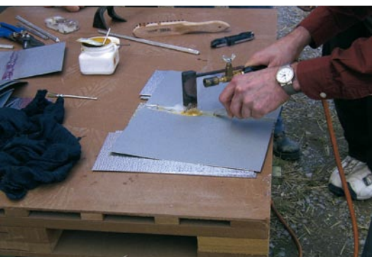
Bild 11.: Erstmals gezeigt auf der Dach + Wand 2004 in München und beim 1. orientalischen Klempnerevent erfolgreich ausprobiert: das Weichlöten von Aluminium.
