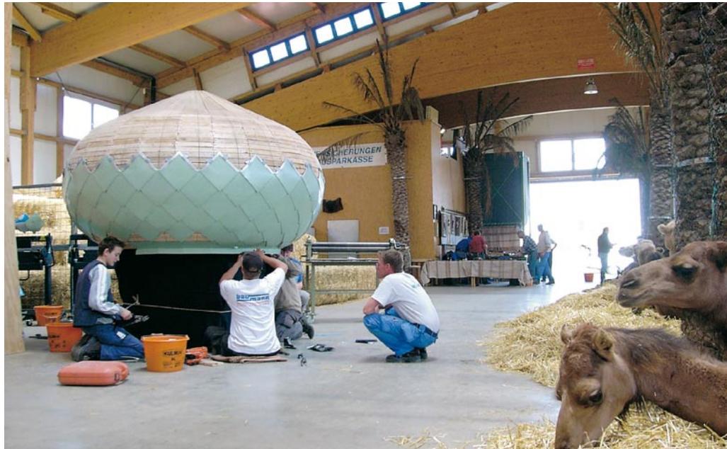
Bild 5.: Klempnerlehrling Michael Ludwig von dem Klempner-Fachbetrieb Lummel (l.) und zwei weitere Klempner arbeiten am Sockel der Turmzwiebel. Klempnermeister Martin Buck (hockend) hat anscheinend die Oberbauleitung übernommen.
