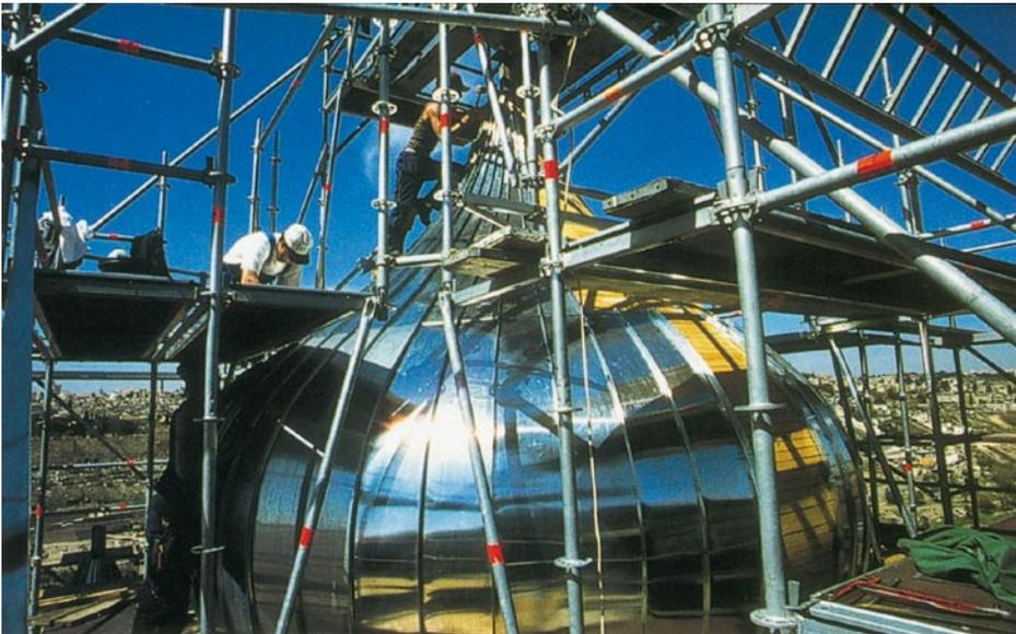
**Schwäbische Klempner bei der Arbeit. Die konisch zugeschnittenen Zinkscharen sind ohne Trennlage verlegt und verlaufen mit absoluter Gleichmäßigkeit.**
