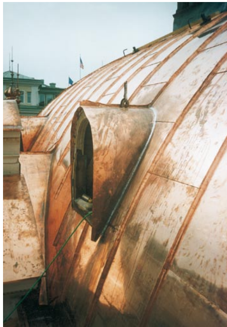
Bild 11.: Eines der Dachfenster ohne ...
