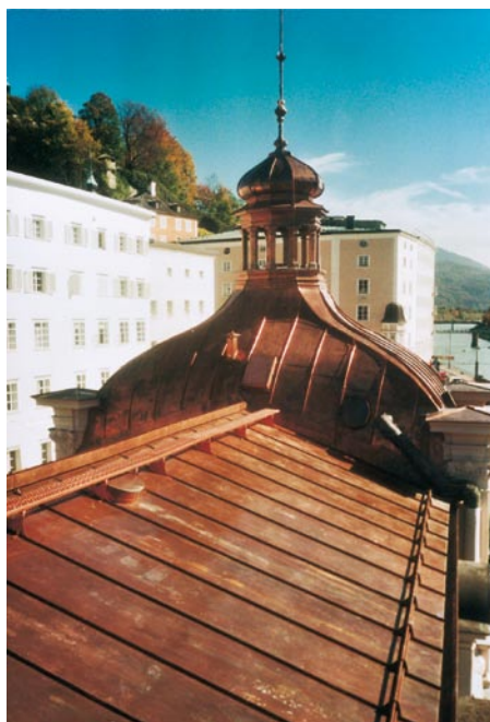
Bild 13.: An den Südturm mit seiner neuneckigen Laterne, dem darüber angeordneten Zwiebelturm und seiner 3 m hohen Turmspitze schließt sich ein Satteldach an, mit einem Laufsteg am First und einer Schneefangvorrichtung an der Traufe.
