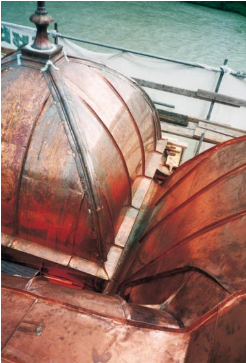
Bild 16.: Kompliziert wurde es aber beispielsweise auch bei dem Übergang von der kleinen Kuppel auf die Hauptkuppel mit der dort erforderlichen Grabenrinne.
