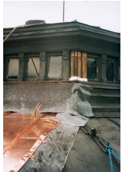
Bild 18.: So sah es während der Bauphase im Bereich der Laterne aus. Die alte Bekleidung aus verzinktem Stahl für die Pilaster (= Wandpfeiler, die nur wenig aus der Wand hervortreten) wurde entfernt und in der Werkstatt neu angefertigt.
