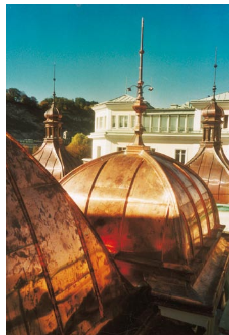
Bild 14.: In der Bildmitte eine der vier kleinen Dachkuppeln mit ihren Ziergratwulsten und der blumengeschmückten Turmspitze. Dahinter die beiden Nordtürme.
