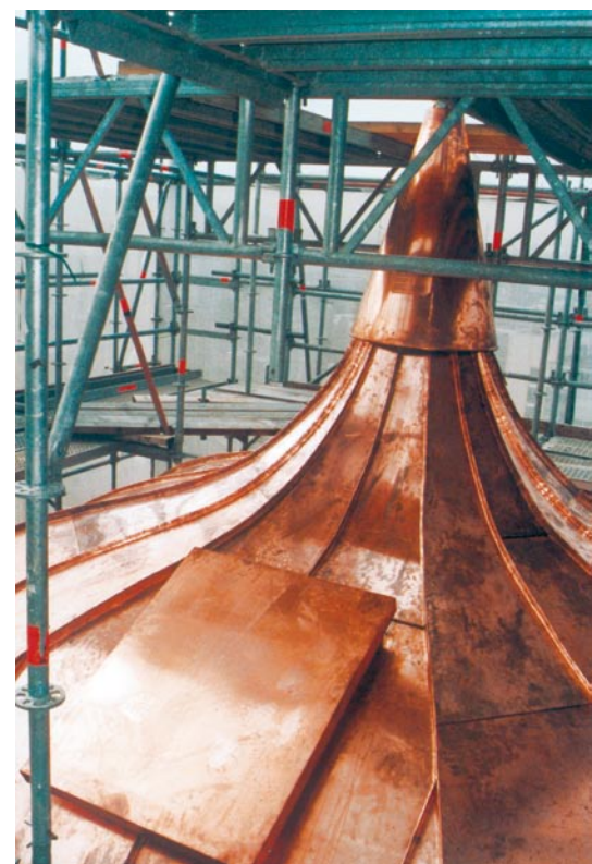
Bild 7.: ... folgt als zweite Haut das Kupferdach.
