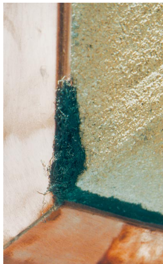
Bild 10.: Dauerhaft dicht: In die Fugen wird Bleiwolle geschlagen.
