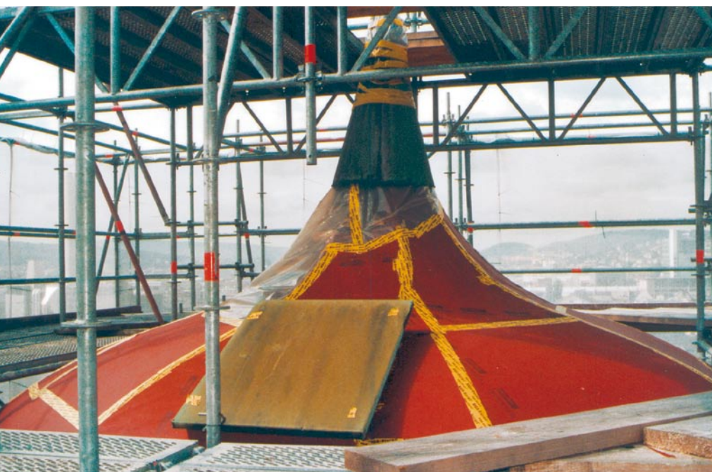
Bild 6.: Während der gesamten Bauphase muss mit provisorischen und dauerhaften Maßnahmen der Wetterschutz gewährleistet bleiben. Auf den wetterfesten Unterbau...
