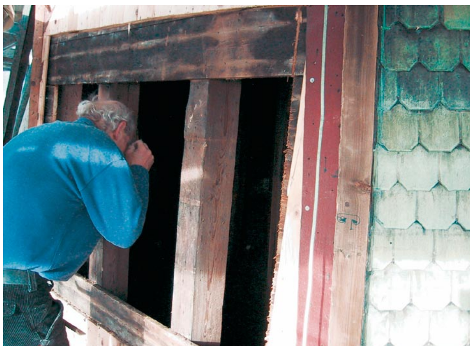
Bild 3.: Das wahre Ausmaß der erforderlichen Restaurationsarbeiten wird aber erst dann erkennbar, wenn das Baugerüst steht und die alte Hülle abgetragen ist.
