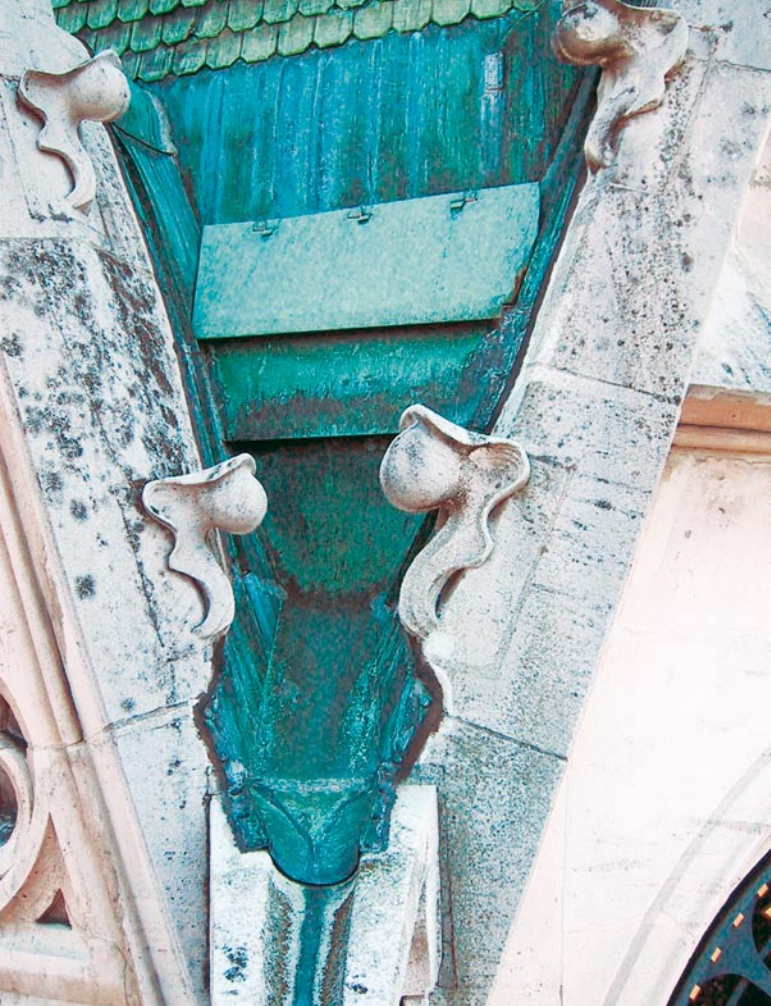
Bild 8: Detail eines Regenabflusses mit einfassendem Mauer Sims aus Sandstein im alten...
