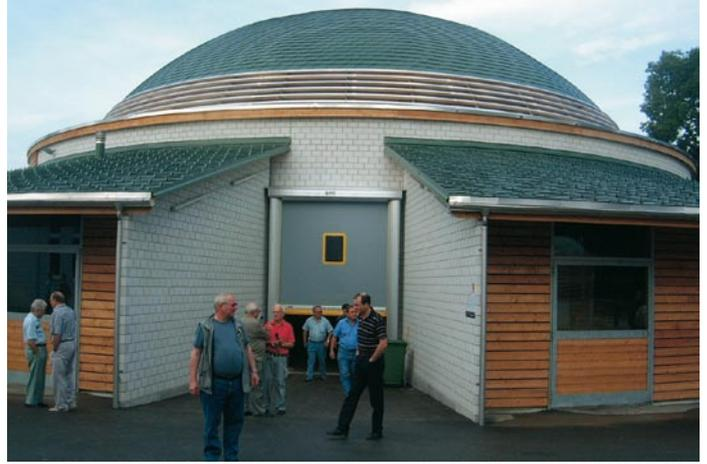
**Die mit Kupfer im Winkelstehfalzsystem bekleidete Fassade des Oberstufenzentrums Thurzelg in Oberbüren überzeugte die Anwesenden.**
