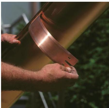
Durch das Spannen des Rinnenverbinders entsteht eine dauerhafte Abdichtung der Naht.
