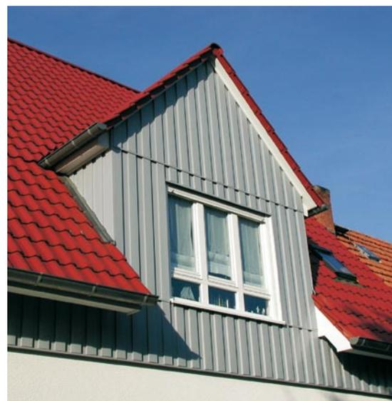
Durch Licht- und Schattenwirkung kommt bei dieser Gaubenbekleidung die gefällige Optik der aus dem Holzbau bekannten Boden-Deckelschalung besonders gut zur Geltung. Werkstoff: Alcan Falzonal, Farbe: zinngrau.
