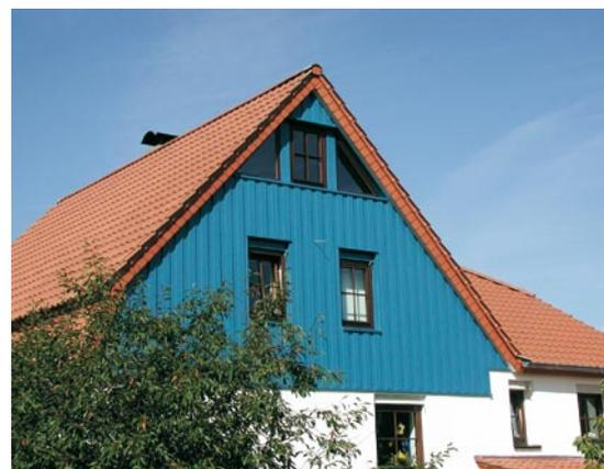
Bekleidung eines Giebels mit dem neuen Metall-Schalungssystem von Lippert. Werkstoff: Alcan Falzonal, Farbe: azurblau.
