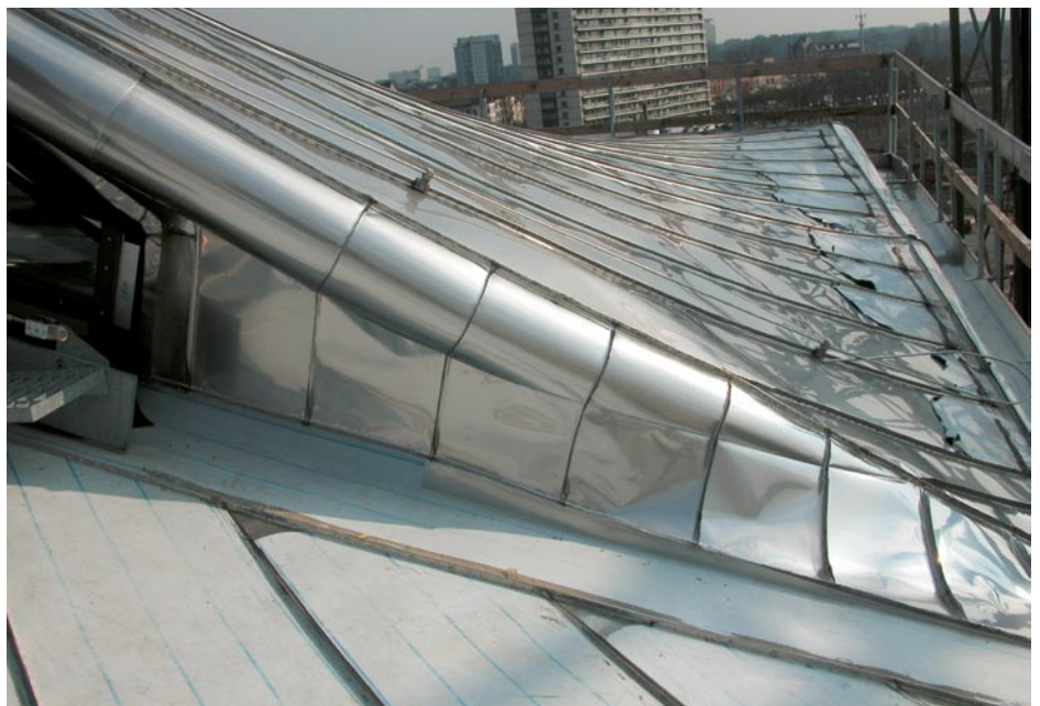
Vor Ort werden noch einzelne Blechteile mit einer Streck- und Stauchzange zugerichtet. Hier der Klempner René Seidel, ein Mitarbeiter des Klempner-Fachbetriebs Alois Baumann aus Mannheim.
