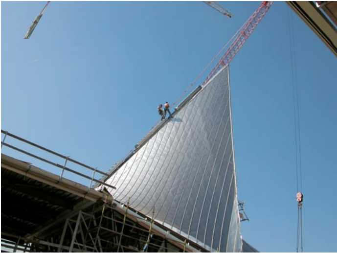
Diese beiden Monteure sind offenbar schwindelfrei.
