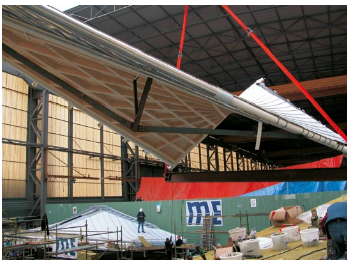
... und eines der Dachelemente ...
