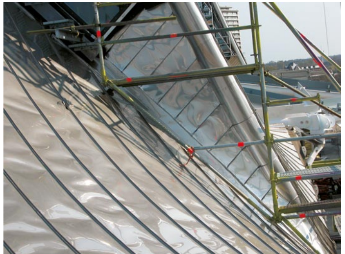
An den Übergängen der verschiedenen geneigten Dachflächen befinden sich Halbzylinder-Teile aus Edelstahl, gefertigt von dem Kurvenspezialisten Guido Krehle aus Landsberg am Lech.
