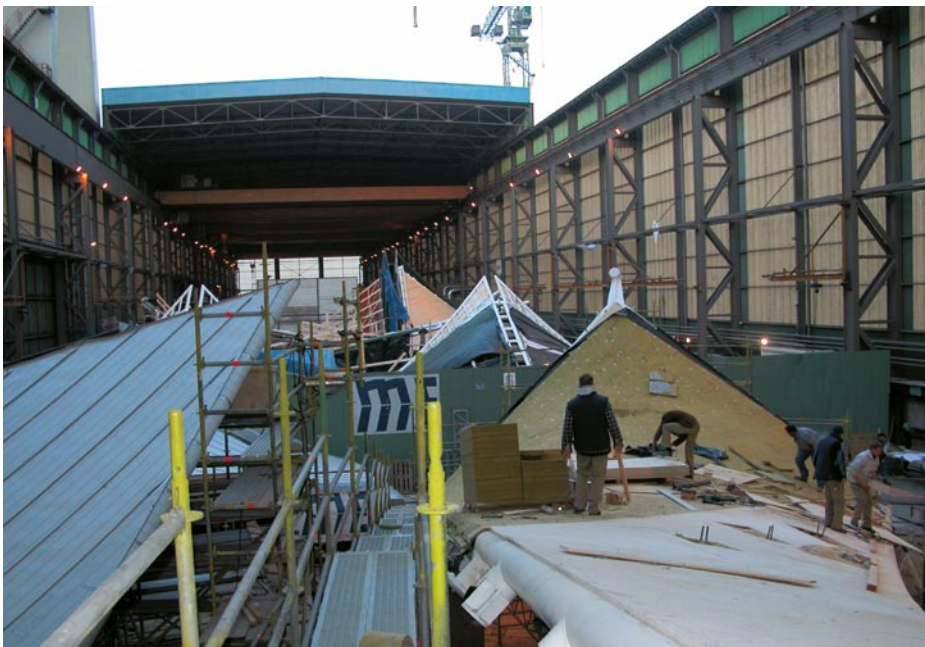
Nach Fertigstellung einzelner Dachelemente öffnet sich das verschiebbare Dach der Schiffswerft-Halle ...
