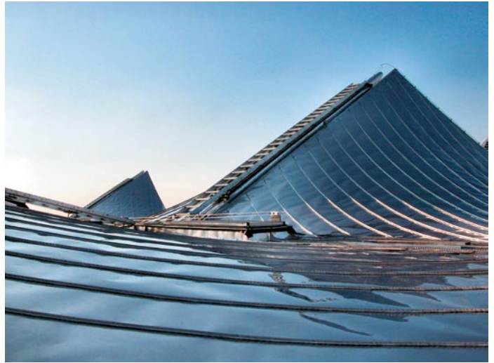
Nicht nur in der Halle der alten Schiffswerft war das Können der Klempner gefragt, sondern auch bei den Arbeiten auf der Baustelle selbst. Zu erkennen ist der Anschluss der Edelstahldachfläche an ein Dachflächenfenster zwischen einem niedrigeren und einem hohen Dachelement.
