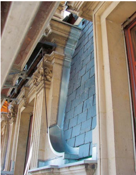
... und für die Winkelbleche mit geschweifter Abdeckung als Anschluss zwischen Dachfläche und Naturstein im unteren Bereich.
