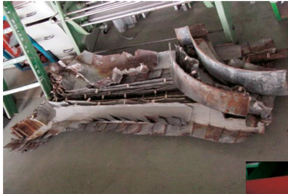
Alte Anschlussbleche wurden sorgfältig demontiert und durchnummeriert.
