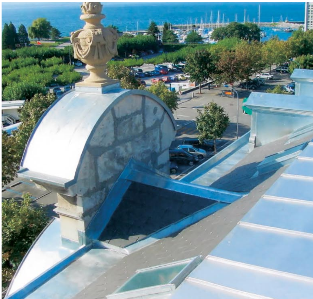
Dieses Bild gestattet einen Blick von der Terasse auf den Neuenburger See, die Rückseite einer Lukarne (geschoss hoher Dacherker in der Hausflucht), die Gesimsrinne, zwei Dachgauben, in das Schieferdach integrierte Dachflächenfenster und das zinkgedeckte Mansarddach.
