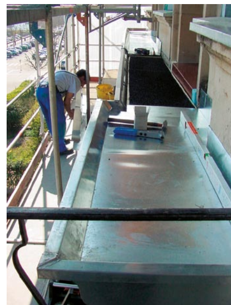
Gesimsrinne und -abdeckung mit strukturierter Trennlage.
