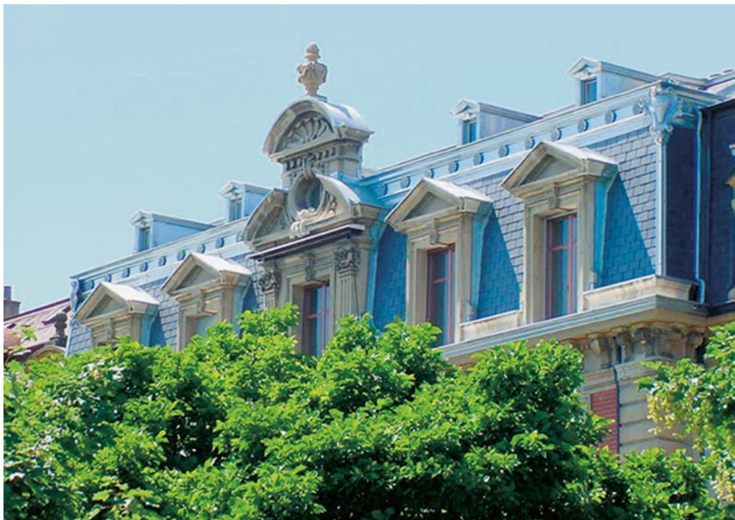
Das Mansarddach vor und nach der Restaurierung.
