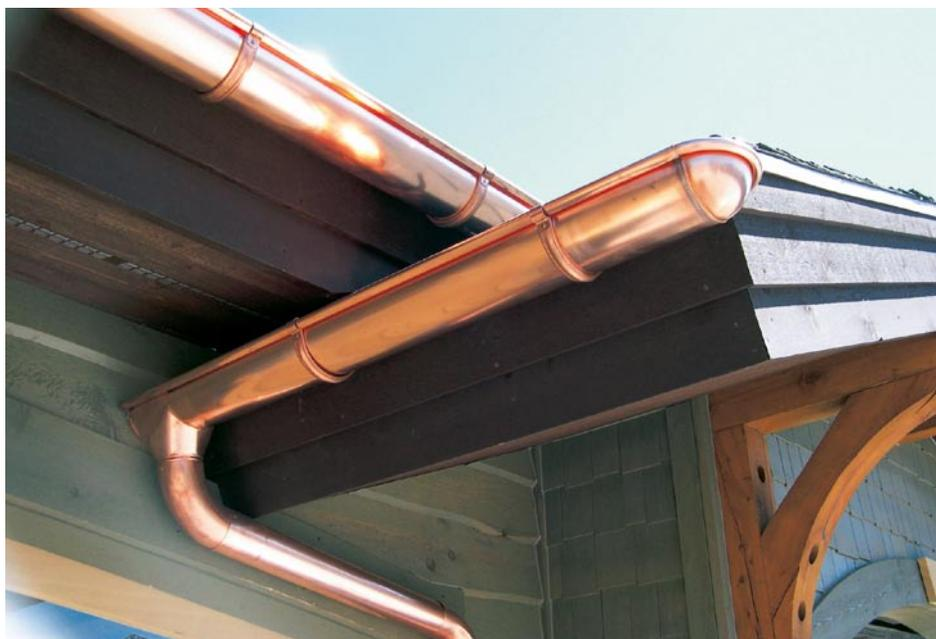
Eine beispielhafte Anwendung von Minoletti - Produkten: Endböden und Einhangstutzen für Dachrinnen.
