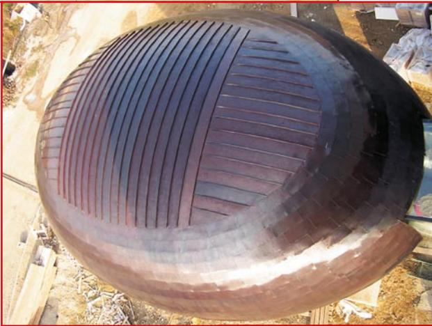
... ist aus Gründen der höheren Wetterdichtigkeit mit Kupferbändern in Doppelstehfalztechnik gedeckt.
