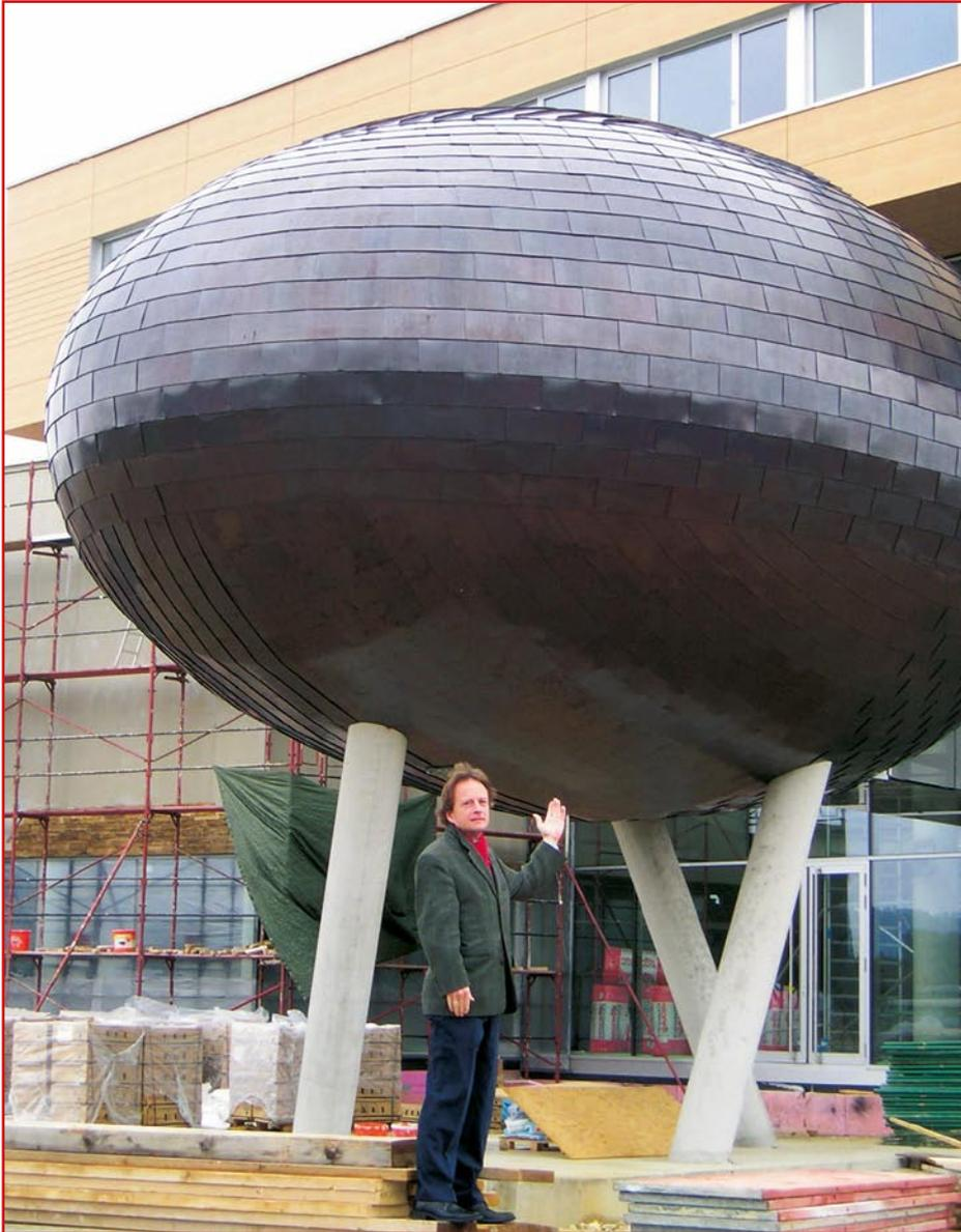
Dierk Mairose, Technischer Berater der KME-Austria, vor der fertig mit Tecu-Oxid bekleideten Kaffeebohne, die auf drei schräg gestellten Stahlbetonsäulen ruht.
