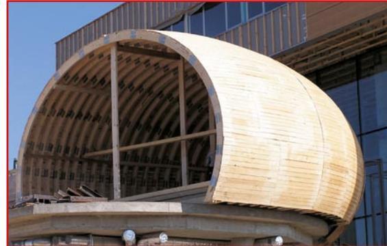
Die Holzunterkonstruktion der Kaffeebohne mit Holzbindern und fertig verlegter Vollschalung
