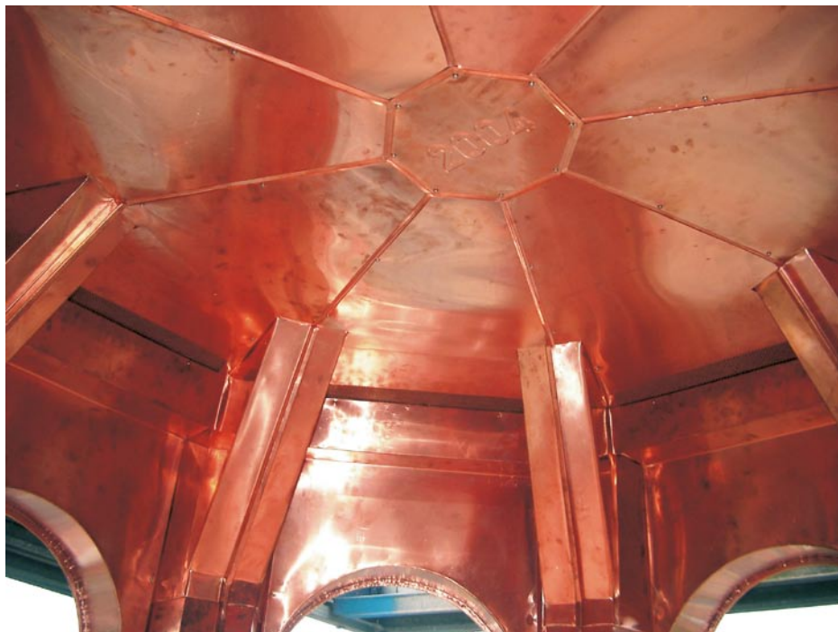
Blick in den Laternenhimmel mit der geprägten Jahreszahl 2004 im Zentrum. Hier sind die Kupfersegmente mit Edelstahlschrauben direkt befestigt.
