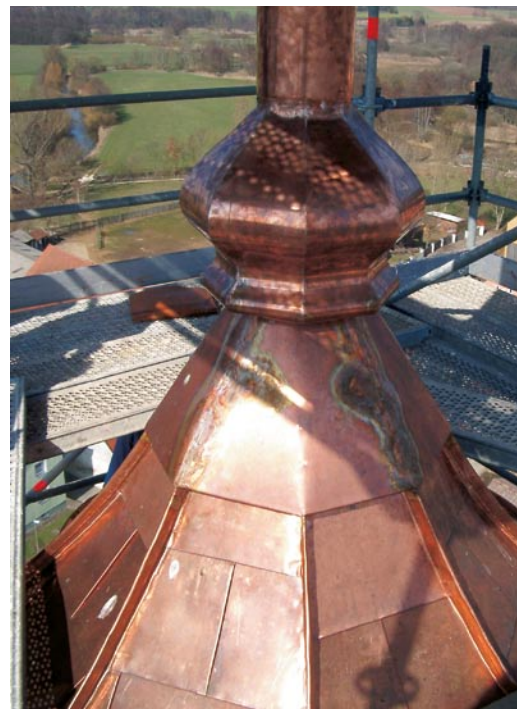
Übergang vom achteckigen Turm zur Turmbekrönung. Die Entlüftung der Turmzwiebel erfolgt unterhalb der Kupferschürze.
