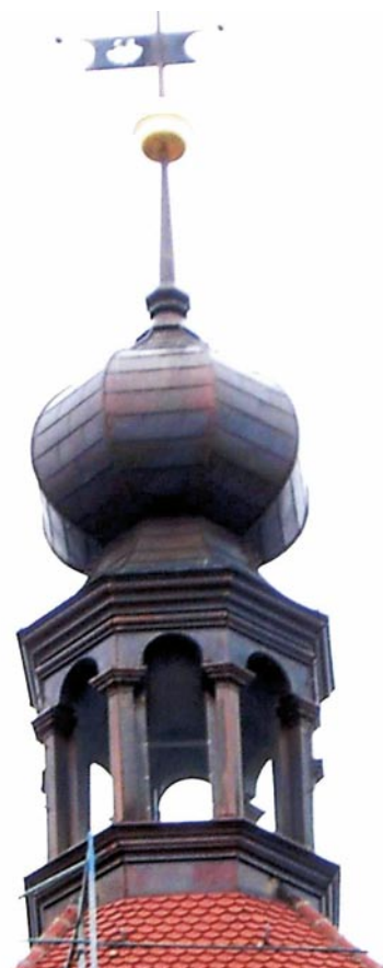
Übergang vom achteckigen Turm zur Turmbekrönung. Die Entlüftung der Turmzwiebel erfolgt unterhalb der Kupferschürze.
