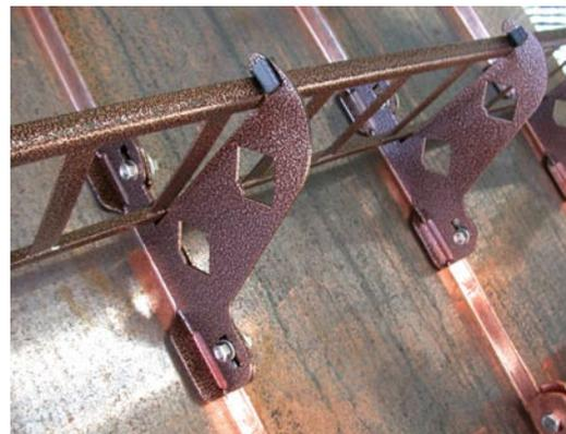
Die Schneefangstützen haben eine Doppelfunktion: Sie können einerseits im vorderen Bereich 150 mm hohe Schneefanggitter aufnehmen.
