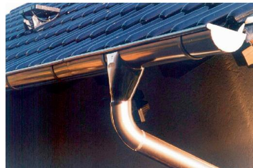
Blanker (glänzender) Edelstahl für die Dachentwässerung an einem Neubau als gestalterischer Kontrast zu blauen Dachziegeln.
