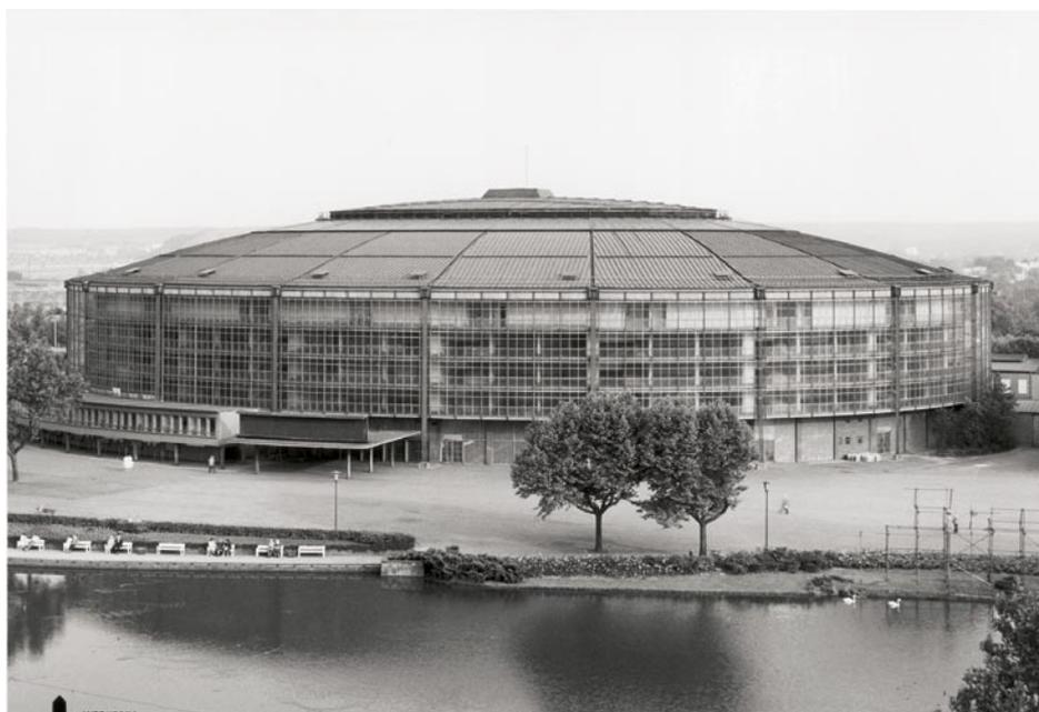
Bild 29.: Ein großes und bekanntes Beispiel aus Deutschland: Das 10 000 m<sup>2</sup> große Dach der Westfalenhalle in Dortmund deckten Klempner des Fachbetriebs Kentzler aus Dortmund im Jahr 1952 mit 0,7 mm dickem Aluminium in Leistentechnik (Foto: Kentzler, Dortmund).
