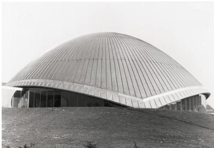
**Bild 35.:** Eines der bekanntesten und ältesten Edelstahldächer befindet sich auf dem Planetarium in Bochum, ausgeführt 1963 durch den Klempnerfachbetrieb Kentzler aus Dortmund (Foto: Kentzler, Dortmund).
