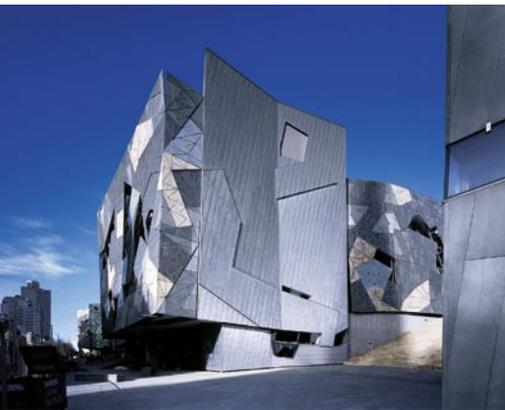
Bild 24.: Moderne Anwendung von Zink in der Architektur: walzblankes und zum Teil auch vorbewittertes Rheinzink für den Federation Square im australischen Melbourne (Foto: Rheinzink, Datteln).
