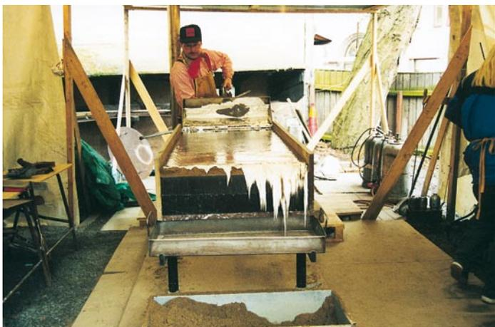
Bild 5.: Das Bleidach des romanischen Doms zu Lund in Südschweden, nordöstlich von Malmö, erneuerte der schwedische Klempnermeister Bror Mårtensson vor einigen Jahren mit von ihm selbst gegossenen Bleiplatten (BAUMETALL 7/2001, Seite 28 ff.).
