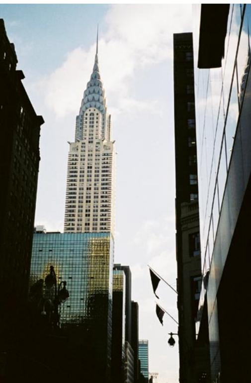
Bild 33.: Das erste Dach aus Edelstahl auf dem im Jahr 1929 errichteten, 381 m hohen Chrysler Building in New York (Foto: Rob van der Zanden, Breda, 2004).
