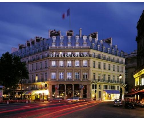
Bild 25.: In Frankreich ist die Leistentechnik mehr verbreitet als in Deutschland. So auch bei der Neudeckung des 2600 m<sup>2</sup> großen Daches auf dem traditionsreichen Hotel du Louvre in Paris mit blaugrau vorbewittertem Titanzink (Foto: Rheinzink, Datteln).
