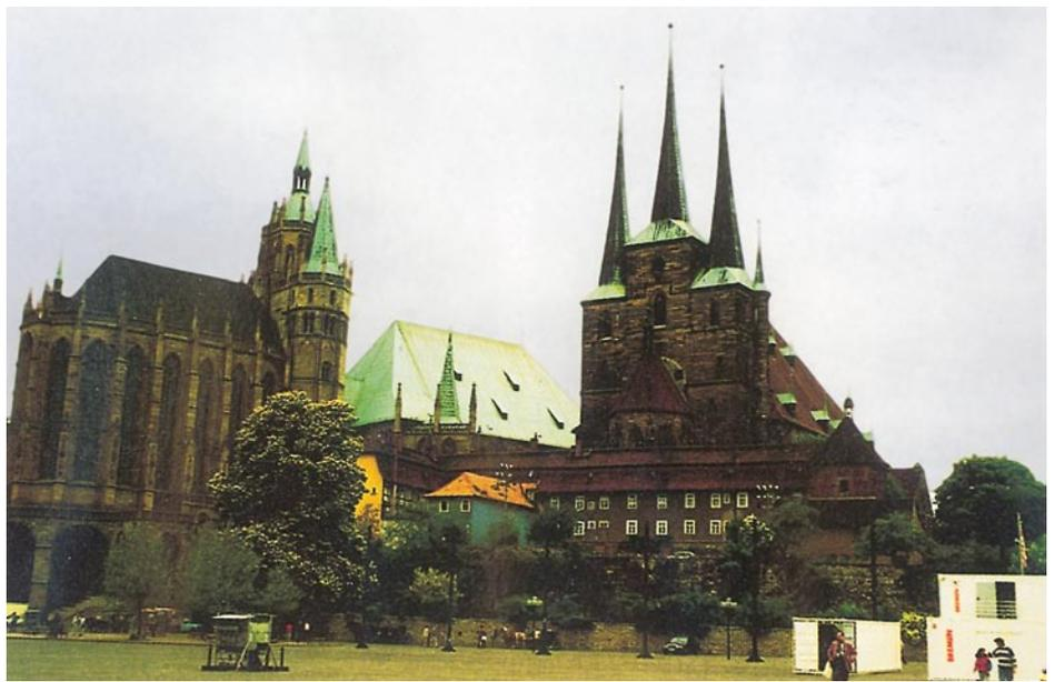
Bild 13.: Der Erfurter Dom mit seinem hochgotischen Chor, erbaut Mitte 12. bis 15. Jahrhundert. Während die Türme patinagrün sind, zeigen die im Jahr 1977 neu gedeckten Dachflächen des Kirchenschiffs eine braune Oberfläche. Rechts daneben die gotische Severikirche mit ihrer Dreiturmfassade. Beide Gebäude vom Marktplatz aus gesehen (Foto: Manfred Haselbach, BAUMETALL 6/1992, Seite 29 ff.).
