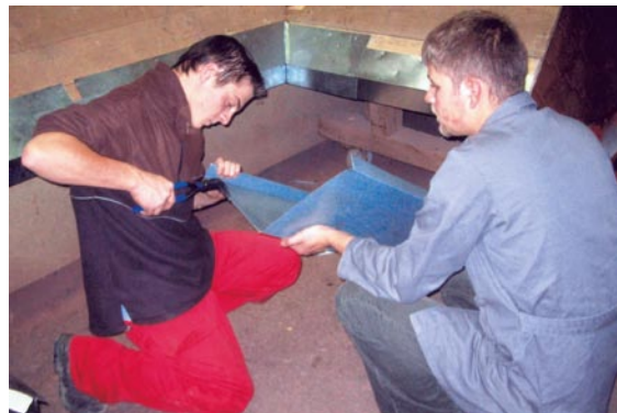
Ein Südtiroler und ein bayerischer Spengler bei der Vorbereitung der Ausschnitte für einen Kehlfalz.
