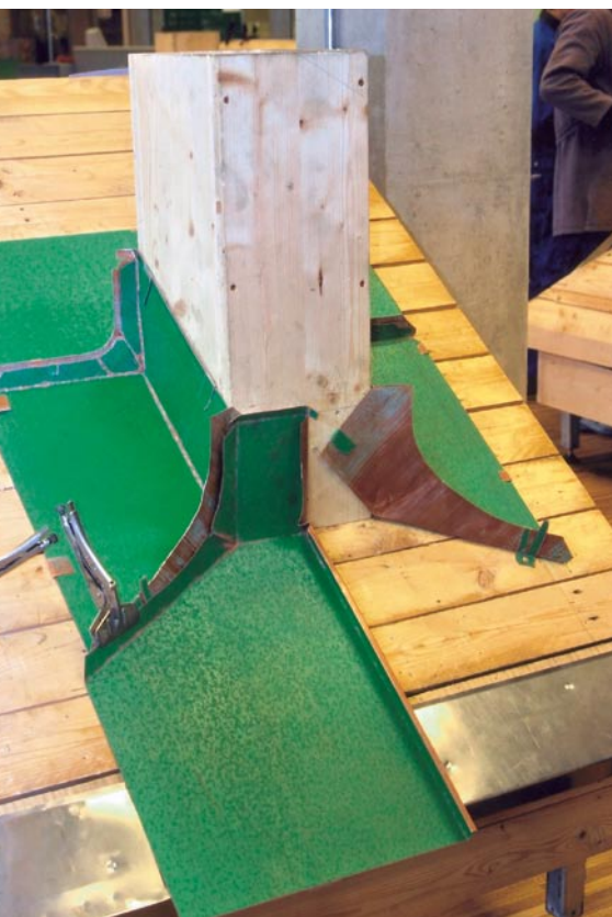
Ein feines Detail: Die Falte des Brustbleches der Schornsteineinfassung ist verdeckt eingearbeitet.
