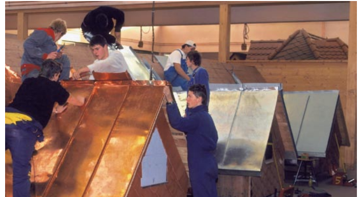
Die Ausführung der Arbeiten wurde von mancherlei Diskussion begleitet, ob nun die „Südtiroler“ oder die „bayerische“ Variante zur Anwendung kommen sollte.
