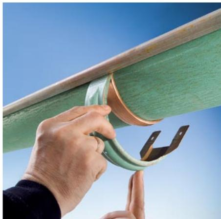
Bild 2.: Montage einer Rinnenhalter-Blende für eine Dachrinne aus Tecu-Patina zur Abdeckung eines Rinnenhalters aus walzblankem Kupfer.
