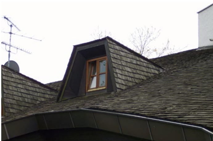
Bild 13.: Dachfläche und Dachgauben vor ...
