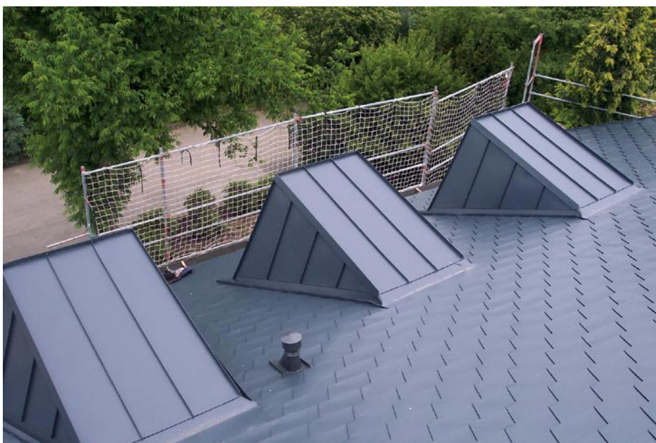
Bild 12.: Die in Stehfalztechnik bekleideten Dachgauben bilden einen angenehmen Kontrast zu den mit Prefa-Dachschindeln gedeckten Flächen.
