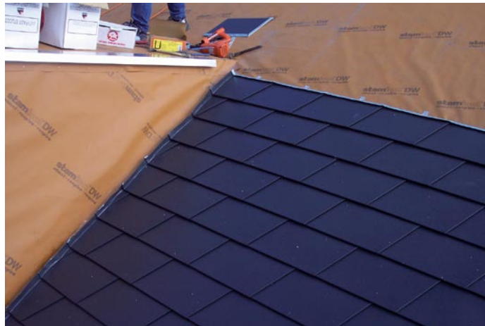
Bild 11.: Aufkantung der Prefa-Dachschindeln im Bereich einer Gaube.
