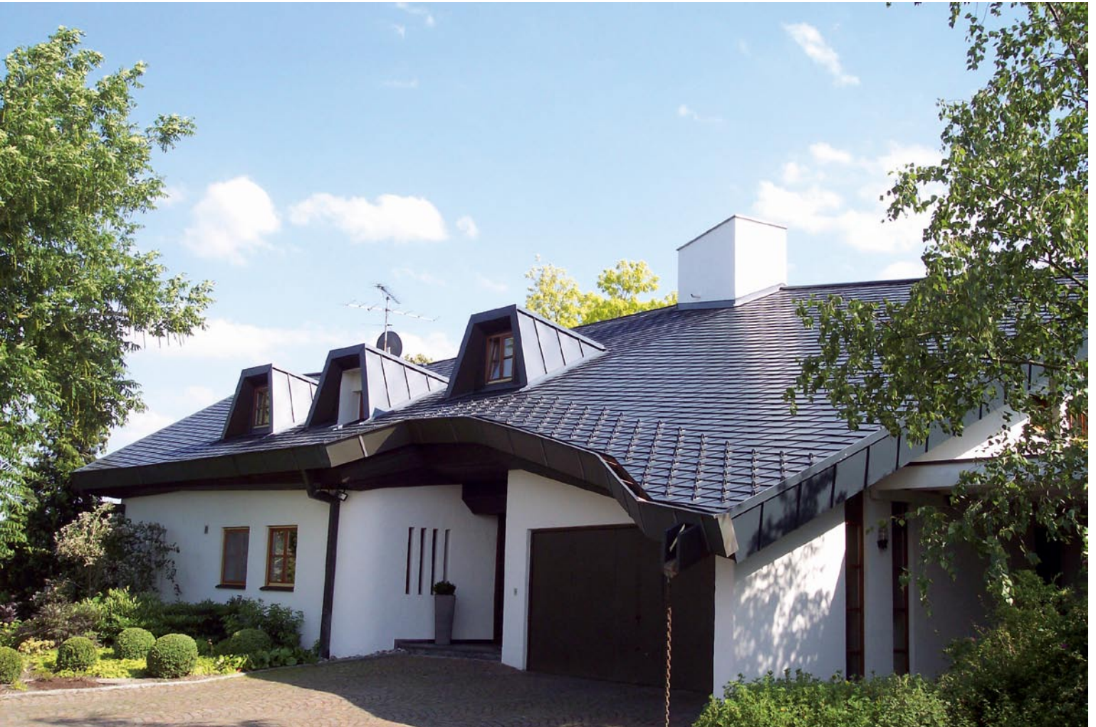
Bild 8.: Der Vergleich mit Bild 1. macht's deutlich: In neuem Glanz erstrahlt das mit Aluminiumschindeln gedeckte Dach des renovierten Wohnhauses.
