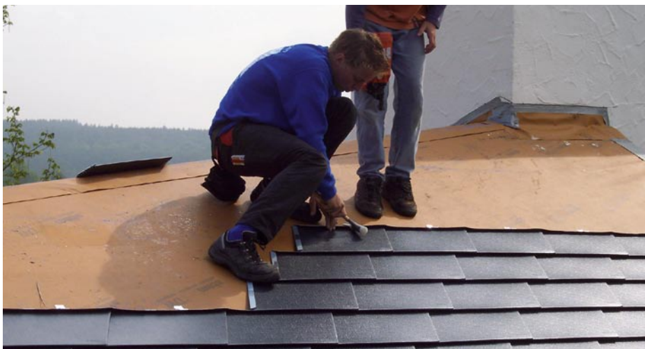
Bild 8.: Der Vergleich mit Bild 1. macht's deutlich: In neuem Glanz erstrahlt das mit Aluminiumschindeln gedeckte Dach des renovierten Wohnhauses.
