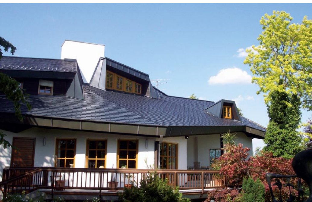
Bild 18.: ... auf der Rückseite des Wohnhauses.
