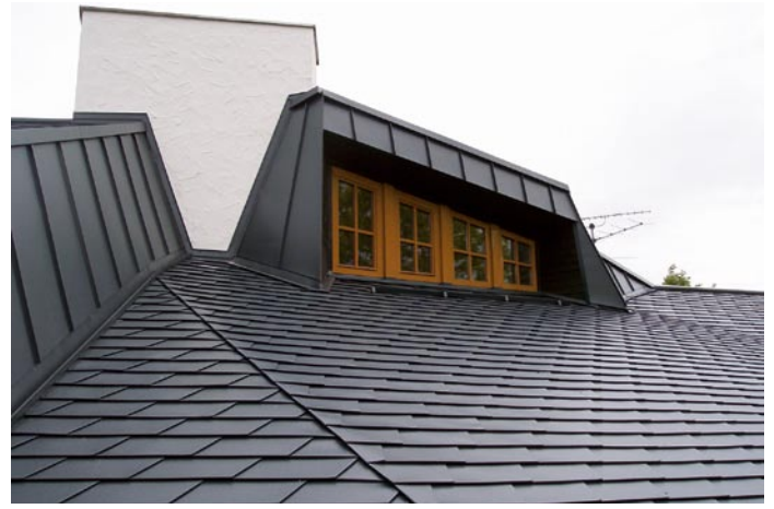
Bild 16.: Das gilt auch für die Bekleidung der Dachaufbauten und die Ausbildung der Grate in der Dachfläche.
