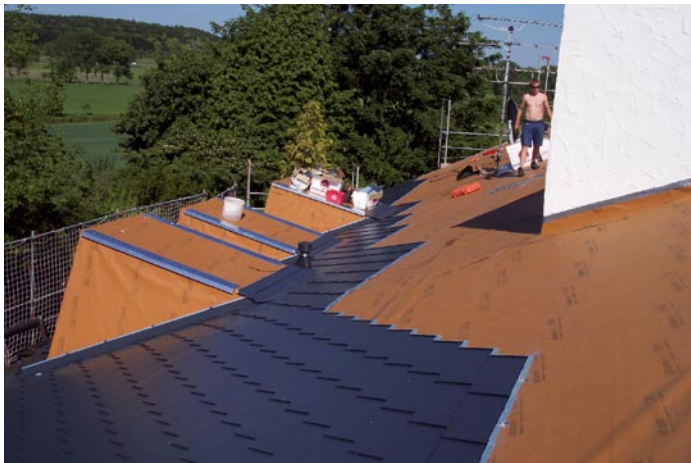
Bild 10.: Blick auf eine Teildachfläche und die im Querschnitt trapezförmigen Dachgauben.
