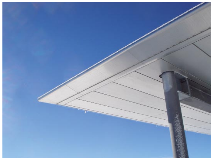
Ein Blick auf den Dachrand und die saubere Einfassung einer Säule.
