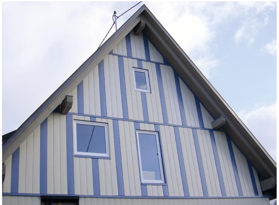
Bild 4.: Eine Giebelbekleidung mit Paneelen aus Farbaluminium lässt eine Beulenbildung gar nicht erst zu.
