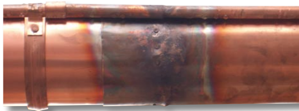
Bild 2.: Beim Hartlöten von Kupferdachrinnen ist eine zusätzliche Verwendung von Nieten nicht erforderlich. Aber man sollte darauf achten, dass man den Werkstoff nicht überhitzt.
