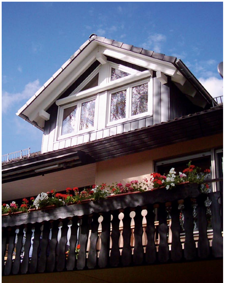
Bild 4.: Eine Giebelbekleidung mit Paneelen aus Farbaluminium lässt eine Beulenbildung gar nicht erst zu.
