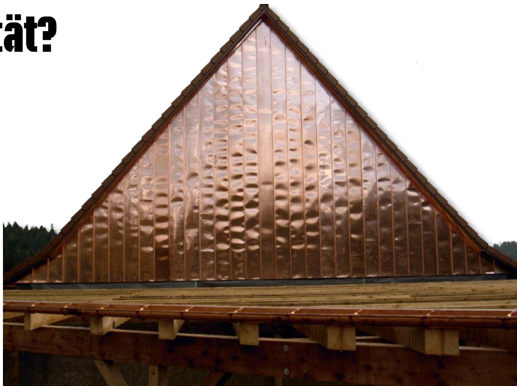
Bild 1.: Auch Außenwandbekleidungen in Winkelstehfalztechnik lassen sich ohne Beulenbildung ausführen, wenn man die notwendigen Fachkenntnisse hat. Diese Giebelbekleidung mit einer maximalen Breite von 9,5 m und einer Höhe von 6,9 m hat ein SHK-Fachbetrieb ausgeführt, ohne das erforderliche Können zu besitzen.
