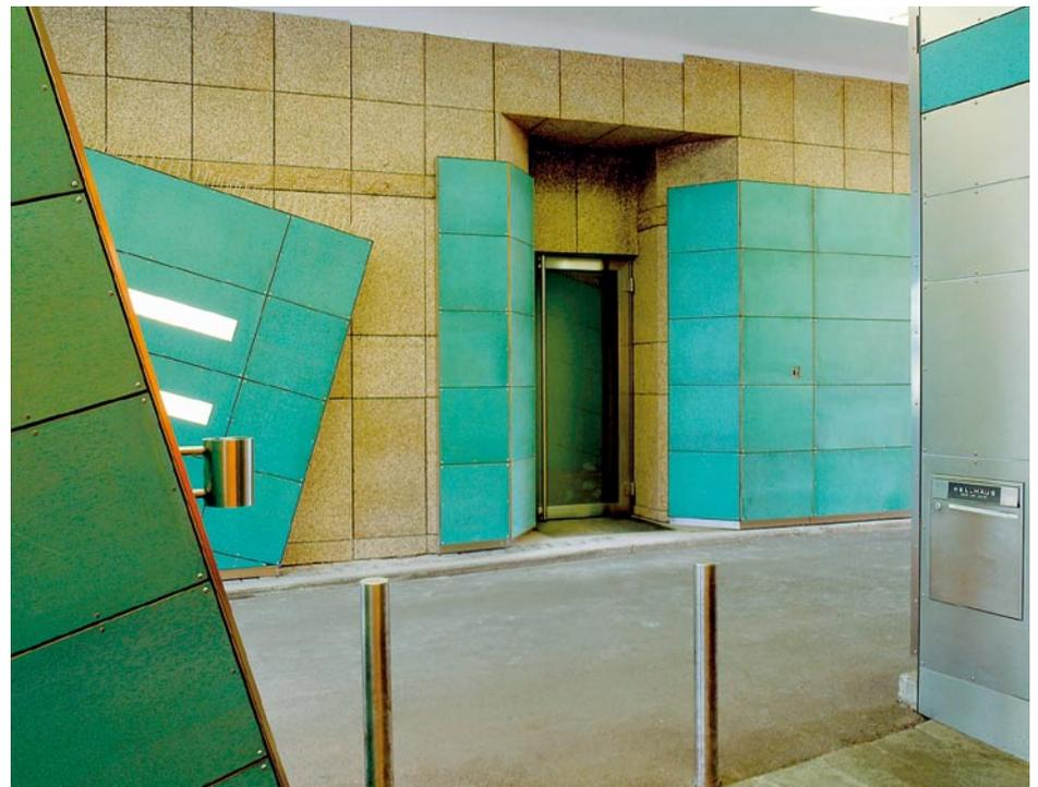
**Bild 6:** ... sind durch kupferbekleidete Platten geschützt, die sich durch die Verwendung von Imbusschrauben leicht auswechseln lassen.
