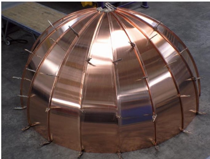
Zur Prüfung der Passgenauigkeit haben Krehle-Mitarbeiter diese Kuppelscharen zusammengestellt und mit Spannzangen fixiert.
